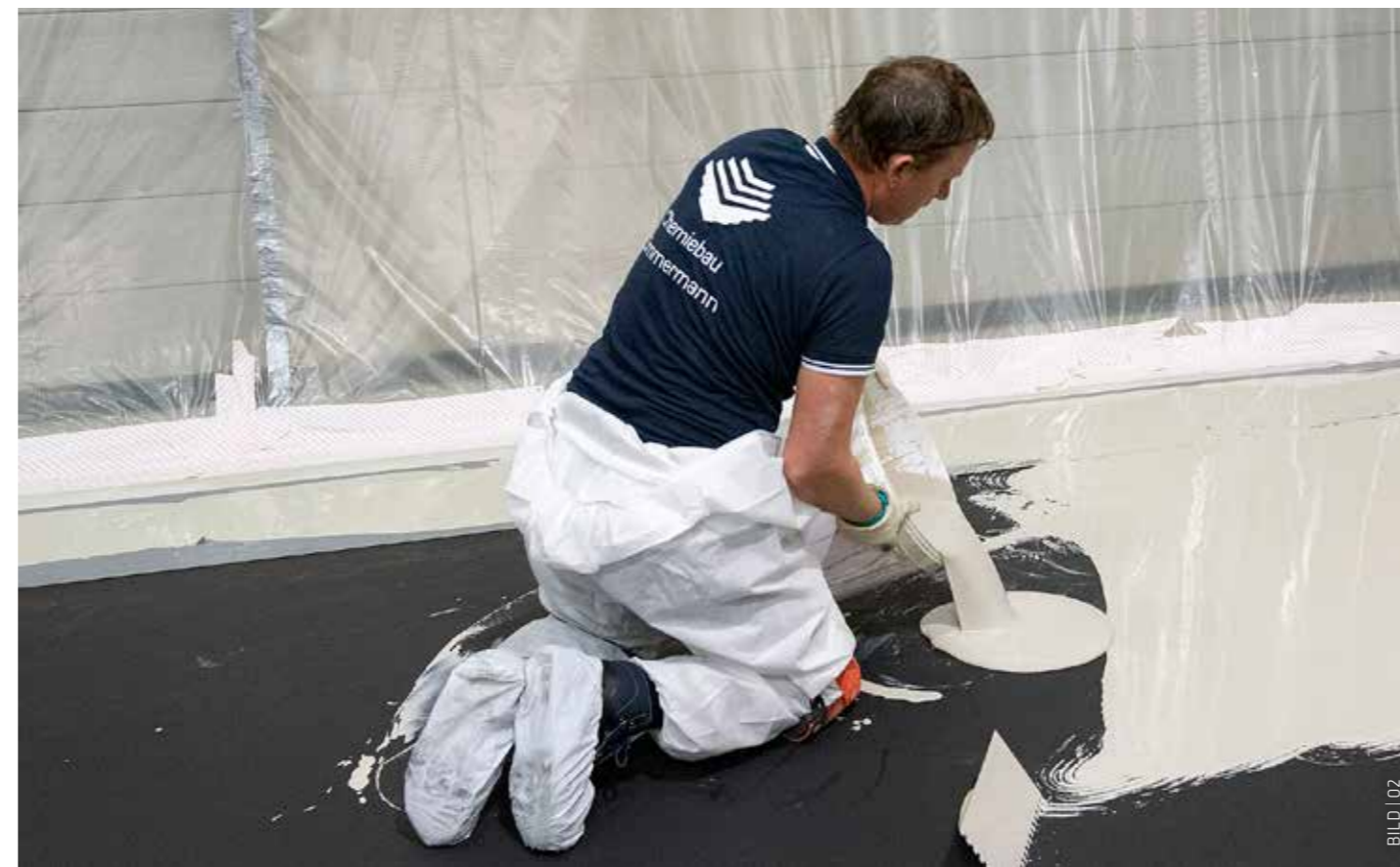
Aufbringen der elektrostatisch ableitfähigen 2K-Beschichtung Sikafloor®-3240 ECF. Das neue Produkt ist wegen seiner Lösemittelfreiheit und den geringen Emissionen für Reinräume mit störanfälliger Elektronik besonders geeignet.
