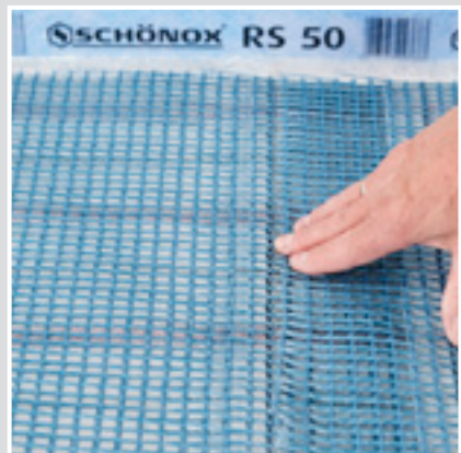
6 Die Bahnen werden an der Längsseite überlappend ausgelegt.
