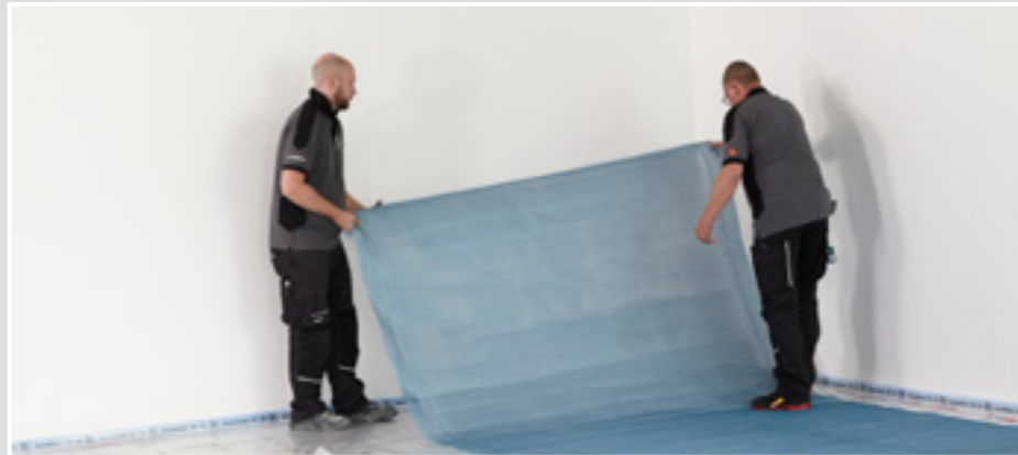
4 Anzahl Bahnen gemäß der Raumgröße ermitteln und die Bahnen ggf. vorab zuschneiden.
