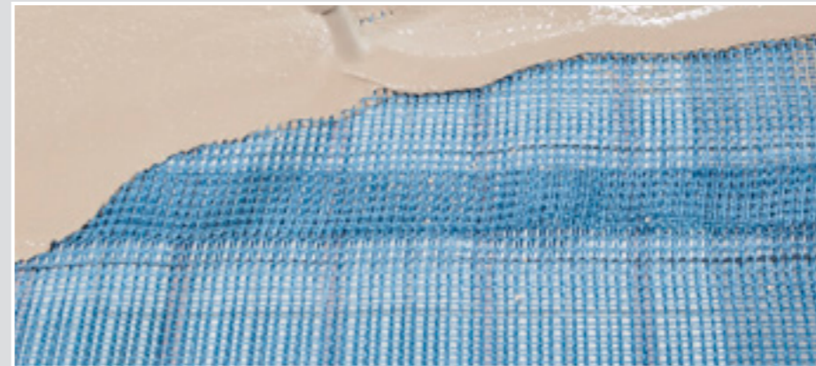
10 WICHTIG: Material nicht gegen den Überlappungsbereich einbringen, um ein Aufschwimmen zu verhindern.
