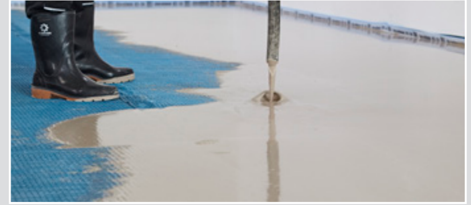
9 Spachtelmasse SCHÖNOX HS 50 einbringen. Bei größeren Flächen wird die Nutzung einer Misch- und Förderpumpe empfohlen.
