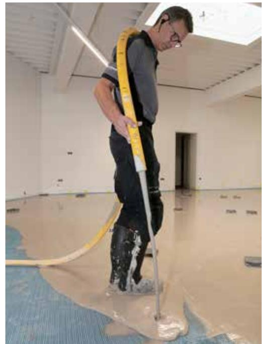
Per Pumptechnik erfolgt die Verteilung der Hybrid-Dickschicht-Spachtelmasse SCHÖNOX® HS 50.
