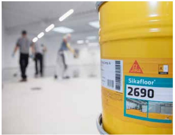
Ein Produkt für die gesamte Beschichtung: Sikafloor®-2690 ermöglicht Grundierung und Versiegelung.
