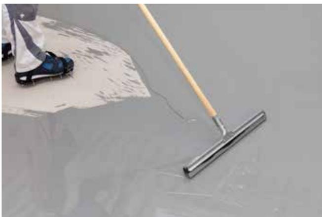
Die Grundierung wird mit Gummiabziehlippen verteilt und abgezogen.
