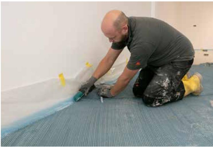
Die SCHÖNOX® RENOTEX 3D Sanierungslösung wird in überlappenden Bahnen ausgelegt.
