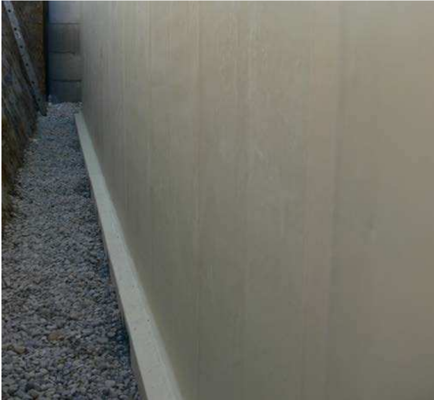
Spannstellen werden nach dem Verschließen mit den systemzugehörigen Stopfen flächig überklebt.
