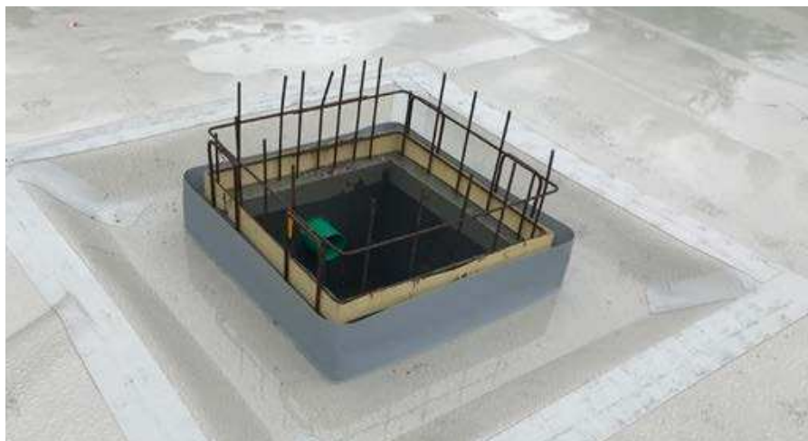
Beispiel für das Andichten eines Fertigteil-Pumpensumpfes mit dem Sikadur-Combiflex® TF System
