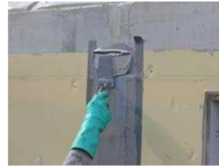
Applikation der Sikadur-Combiflex® TF Abklebung mit Anschluss an SikaProof®
