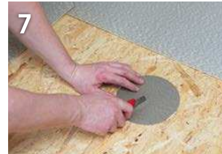
7 Passstück aus Innentape herstellen
