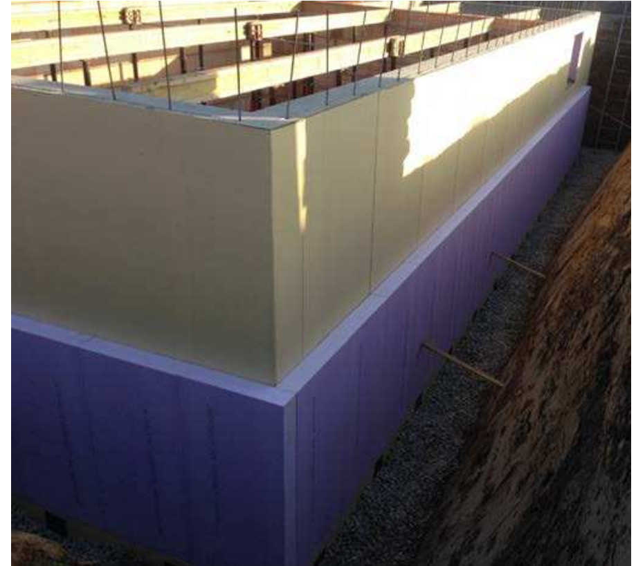
Perimeterdämmung aus druckstabilen XPS-Platten
