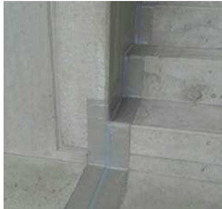
Abdichtung einer Dehnfuge mit dem Sikadur-Combiflex® TF System
