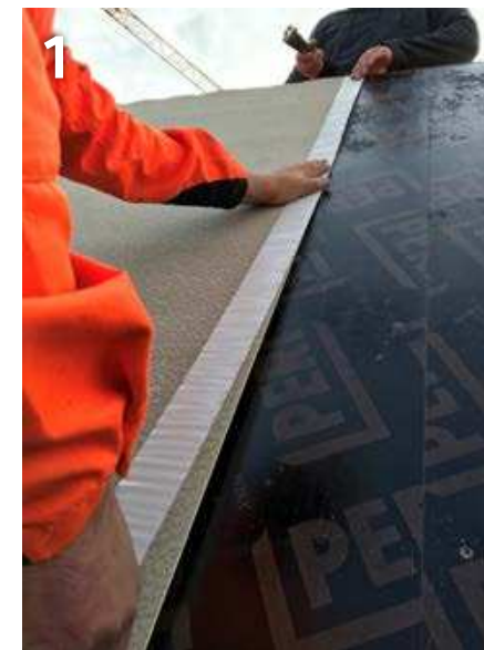
Aufkleben des SikaProof® Sandwichtape auf der unten liegenden Bahn
