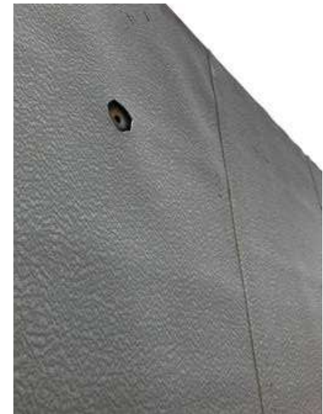
Horizontale Stöße in zweihäufig geschalteten Bereichen immer nach dem Regenschirmprinzip anordnen
