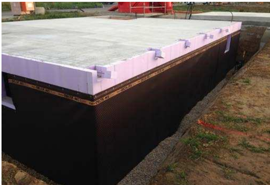
Verfüllung des Arbeitsraumes möglichst umgehend nach der Fertigstellung des Verbundsystems
