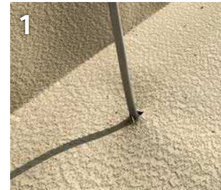
1 SikaProof® A+ Bahn passgenau ausschneiden oder erwärmen und über den Fundamenterder ziehen.
