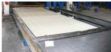
Einlegen der vorkonfektionierten Bahn auf den Schalwagen
