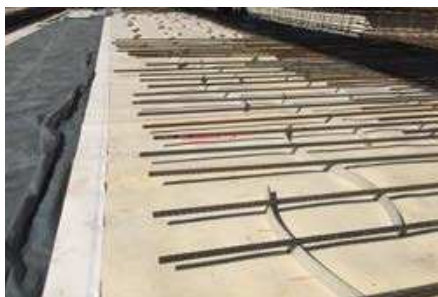
FBV-Bahnen im Anschlussbereich ausreichend bis über die längste Anschlussbewehrung vorstrecken
