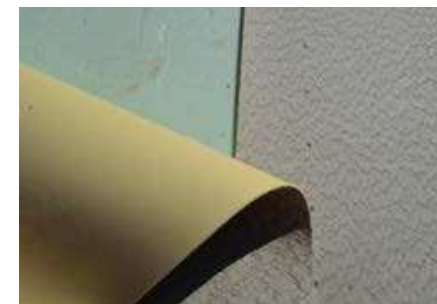
Verlegemarkierung zum einfachen Ausrichten der Überlappungsbreite von 5 cm
