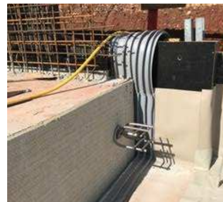
Dehnfugenausbildung mit dem Sikadur-Combiflex® TF Fugenbandprofil DFT 330
