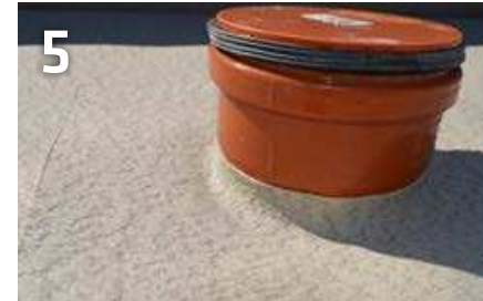
5 Durch die thermische Formbarkeit des SikaProof® A+ Materials wird so eine passgenaue Manschette ausgebildet.
