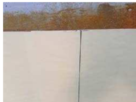
Überlappungsstoß mit doppelter Verlegemarkierung: Die obere Bahn ist vor dem Verkleben so auszurichten, dass der Rand zwischen den beiden Verlegemarkierungen liegt.
