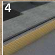
4 Arbeitsfugenabdichtung, z.B. Sika® Fugenblech-FBV oder KAB-Fugenband
