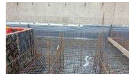
SikaProof® A+ im Sohle-Wandbereich durchgelegt: Der Verlegeuntergrund im einhäufigen Wandbereich ist ausreichend hoch vorbereitet und SikaProof® bis über die Anschlussbewehrung vorgestreckt. Eine auf Höhe angebrachte Folie schützt den Anschlussbereich vor Betonverschmutzungen.
