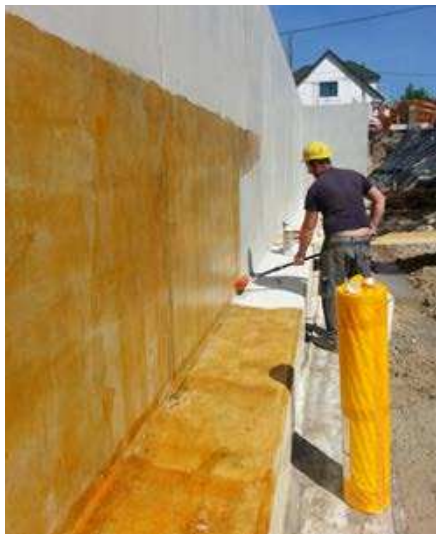
Auftrag des SikaProof® Primer-01
