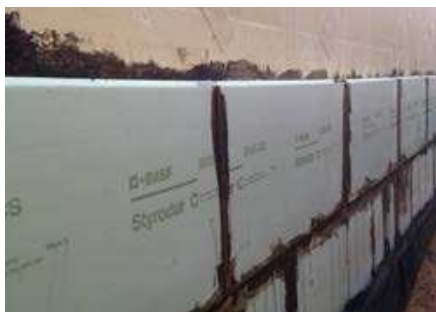
Vollflächige Verklebung der Perimeterdämmung
