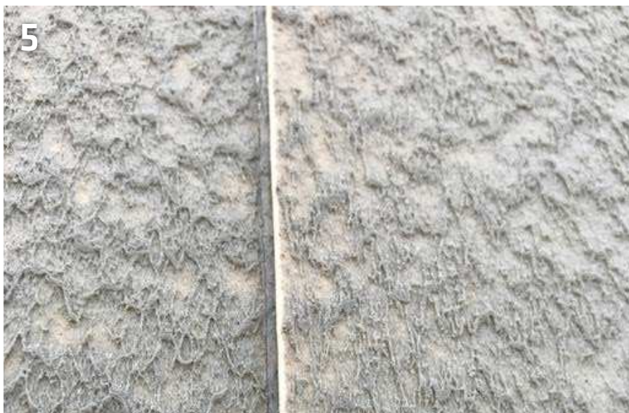
Die Naht muss kapillarfrei bis zur Verbundzone verklebt sein
