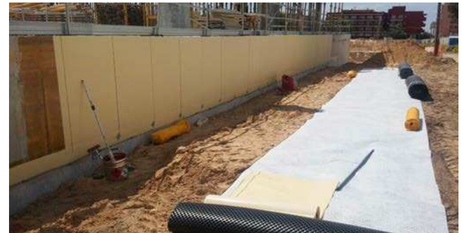
Überbrücken der Arbeitsfuge mit SikaProof® P-12 und direkter Anschluss an die bestehende Fläche aus SikaProof® A+ in Kombination mit einer zusätzlichen innenliegenden Fugenabdichtung
