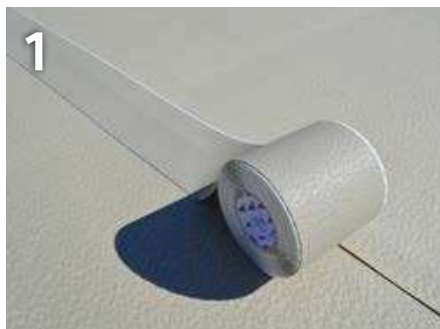
SikaProof® Tape A+N mittig über der Naht ausrichten
