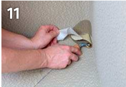
11 Mit geeignetem Roller im Eckbereich sorgfältig anrollen
