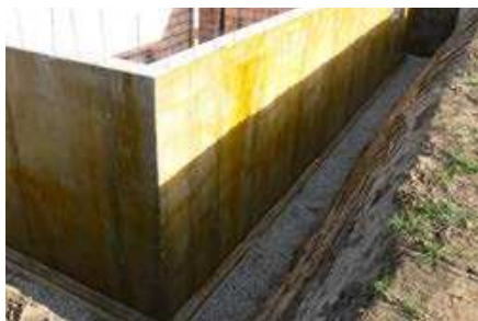
Fertig vorbereitete Fläche; nur soviel vorbereiten, wie am selben Tag überarbeitet werden kann
