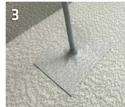
3 SikaProof® Tape A+ zurechtschneiden, über Fundamenterder ziehen und auf Verbundschicht verkleben
