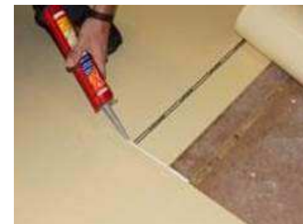
Bei drückendem Wasser über 5 m Wassersäule: Versatz der T-Stöße oder Detailstöße zusätzlich mit Dichtstoff sichern (SikaFlex® 11FC), raupenförmig auftragen (2 - 3 mm) und anschließend mit Handroller kräftig anreiben.
