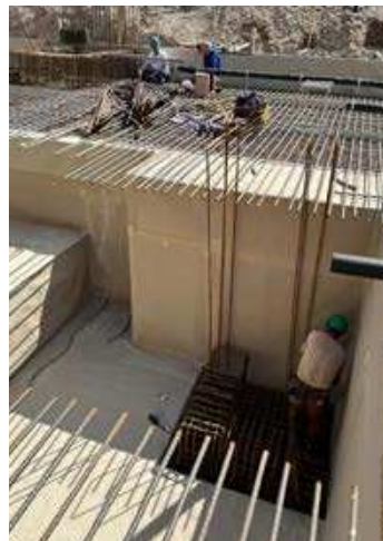
Bewehrungsarbeiten auf Flächen mit SikaProof® mit entsprechenden Schutzmaßnahmen
