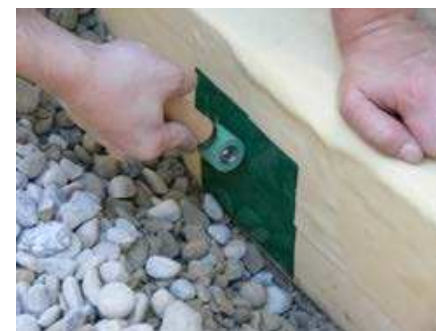
T-Stöße mit SikaProof® ExTape-150 sichern und mit Handroller kräftig andrücken
