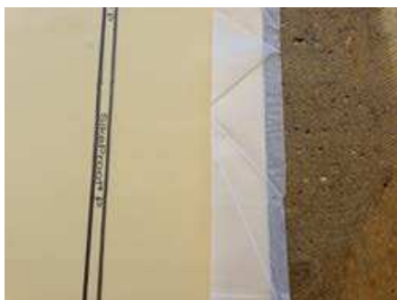
Zusätzlicher Kleberand am Längsstoß: Schutzliner vor dem Verkleben der überlappenden Bahn abziehen.
