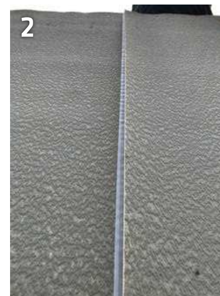
Ausrichten der Überlappung der oben liegenden Bahn
