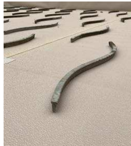
Linienförmige Abstandhalter aus Faserzement, auf schmale Seite verlegt und lageversetzt angeordnet
