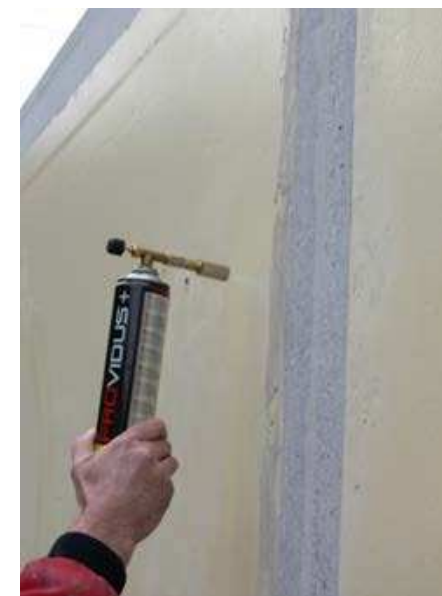
Untergrundvorbereitung durch kurzzeitiges Beflammen von SikaProof® im Überlappungsbereich vor der Applikation des Sikadur-Combiflex® TF Systems
