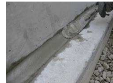
Herstellen einer Hohlkehle
