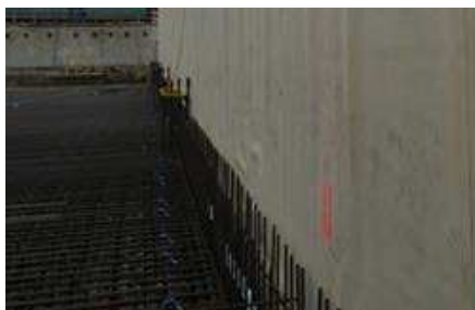
Einhäufigt geschalter Wandbereich mit vollflächiger Verklebung der Perimeterdämmung
