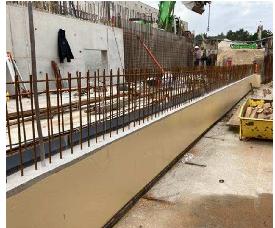
Ausgeschaltete Bodenplattenstirnseite in zweihäufig geschaltetem Bereich.
