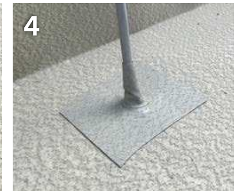
4 Zweites SikaProof® Tape A+ zurechtschneiden und Übergang zu Fundamenterder andichten.
