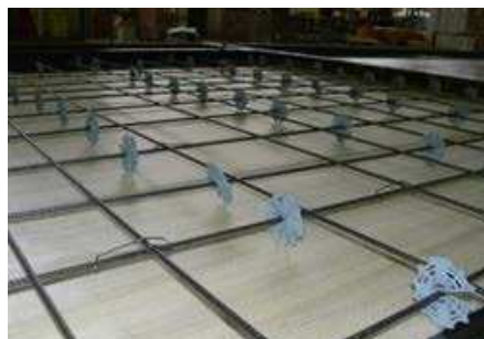
Einbau der Bewehrung
