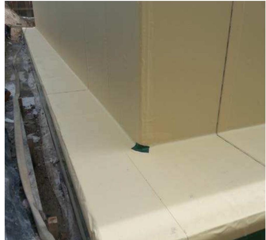
Abschließendes Versiegeln und Sichern der Detailausbildung gemäß Kapitel "4.6 Stoßausbildung"
