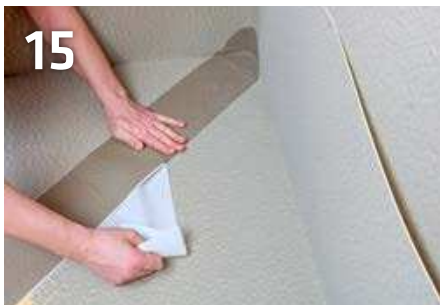
15 Schutzliner abziehen und anreiben
