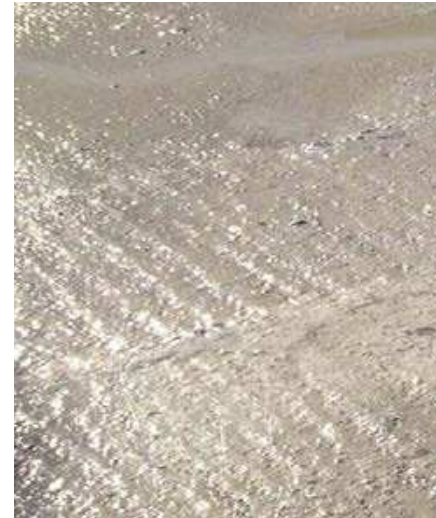
Bodenplatte mit Magerbetonsauberkeitsschicht: fließfähig einbauen und schwabbeln, damit das Korn absinkt
