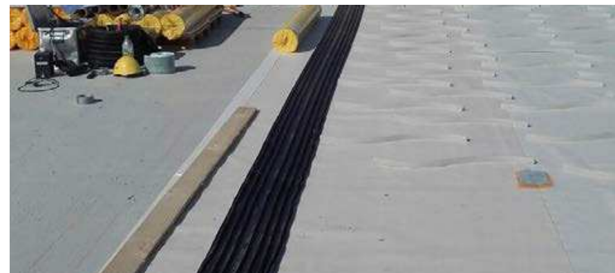
Dehnfugenausbildung mit einem Sika Tricomer®-Fugenbandprofil DA 320/3
