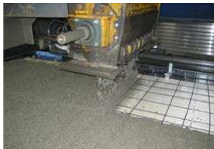
Betonage der Fertigteilenelemente
