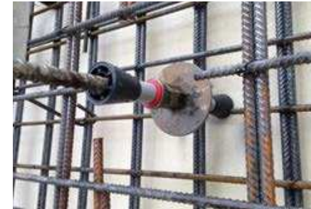
Installation der Spannhülse
