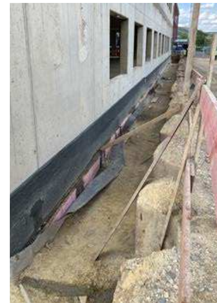
Weiterführende Abdichtung im Sockelbereich mit SikaTop®-126 Pro
