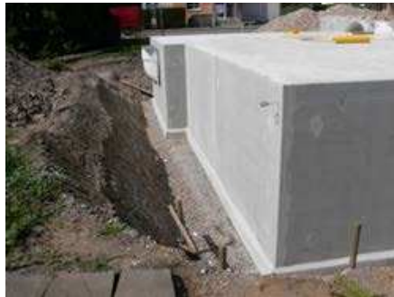
Beispiel eines Fertigteilkellers aus Elementwänden
