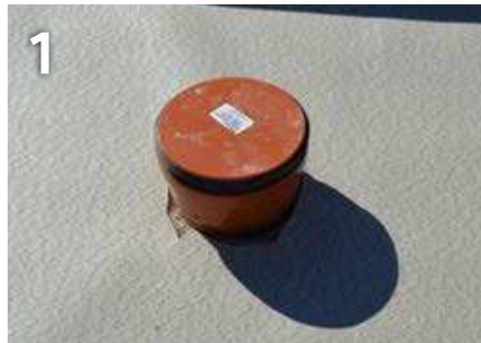
1 Fläche verlegen und Rohrdurchführung grob ausschneiden.
