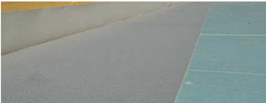
Thermische Umformung der Bahnen für das Verlegen der Randaufkantung
