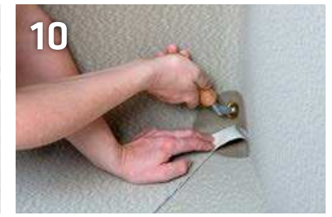
10 Mit geeignetem Roller im Eckbereich sorgfältig anrollen
