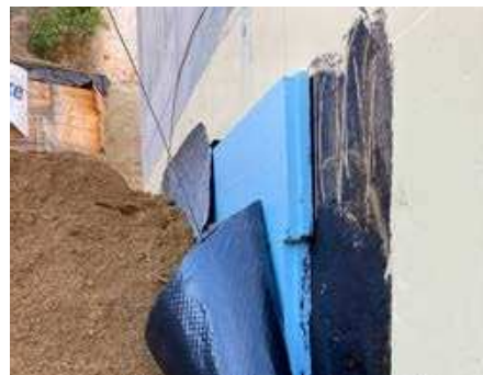
Befestigung von Perimeterdämmung mit lösemittelfreier 2-komponentiger PMBC
