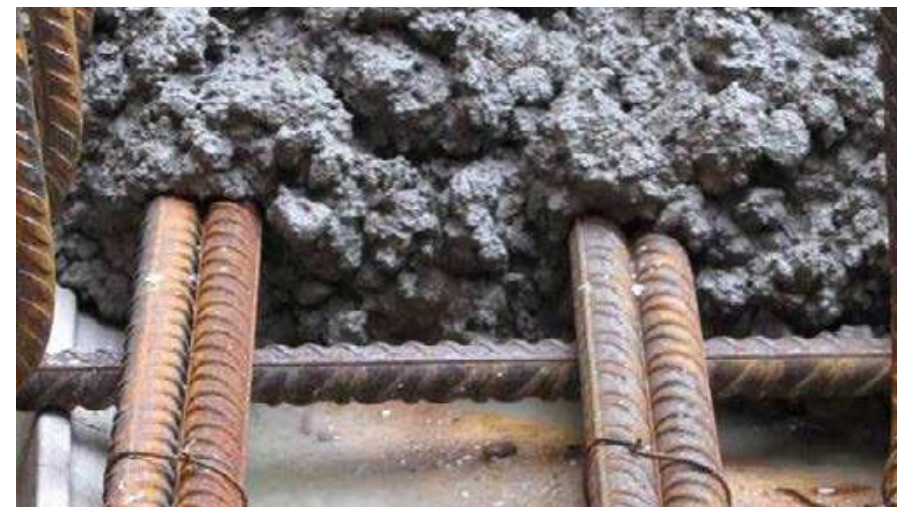
Betonage der SikaProof® A+
