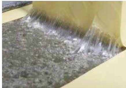
Vollflächiger Verbund durch Hochleistungs-Kontaktverklebung mit Systemprimer
