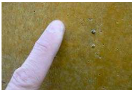
Fingerprobe zur Beurteilung: Vor der Applikation von SikaProof® P-12 muss der SikaProof® Primer-01 berührtrocken sein.
