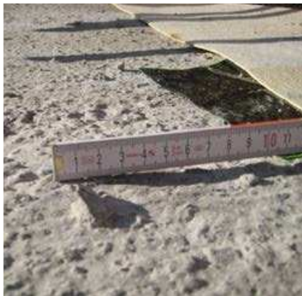
Abkehren von losen Steinen und Abstoßen und Entfernen von spitz herausstehenden Bestandteilen
