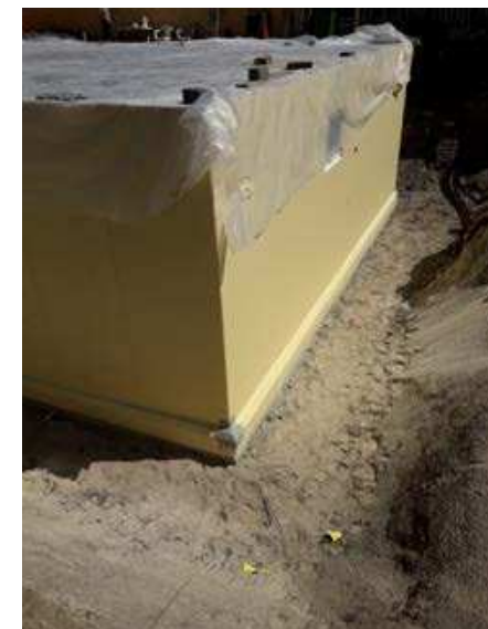
Weiterführende Abdichtung mit SikaProof® P-12 im Wandbereich
