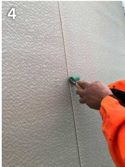
Kräftiges Anrollen / Anreiben der Nahtverklebung
