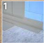
1 SikaProof® A+, vorapplizierbares Frischbetonverbundsystem
