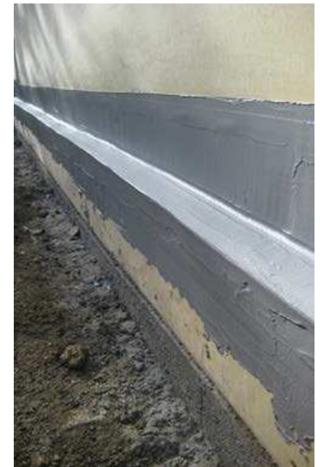
Fertig applizierte Sikadur-Combiflex® TF Abklebung mit Anschluss an SikaProof®
