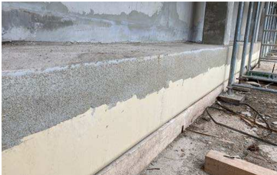
Übergabestreifen aus Sikadur-Combiflex® CF Kleber mit Absandung zur Aufnahme anzuschließender Beschichtungen
