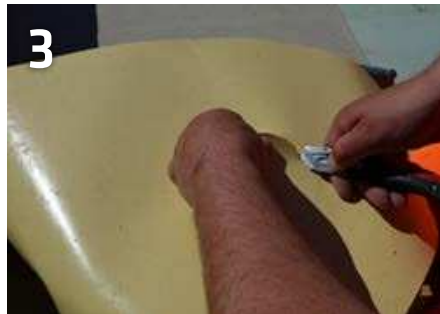
3 Angezeichneten Kreis mit ca. 2-4 cm kleineren Radius (abhängig von Dimension des Rohres) ausschneiden und Bahn um den Ausschnittbereich auf der Rückseite mit Heißluft erwärmen.
