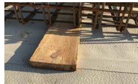
Lagerholz für das Zwischenlagern eines vorgebundenes Bewehrungskorbes
