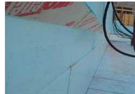
Verzahnungen und Rücksprünge in einhäufigen Bereichen im 45°-Winkel ausbilden
