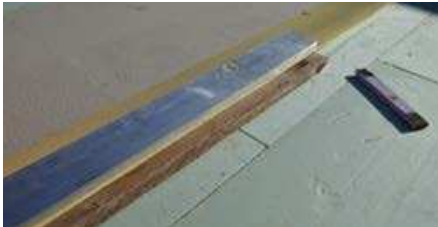
Thermische Umformung der Bahnen für das Verlegen der Randaufkantung
