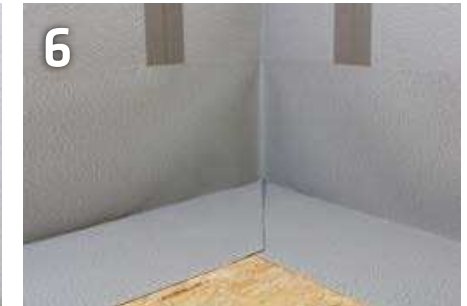
6 Umklappen und Quetschfalte herstellen
