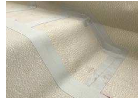
Ausbildung von Sonderecken im Voutenbereich
