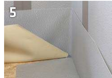
5 Ausschnitt nicht bis ins Eck! Material für Quetschfalte stehen lassen
