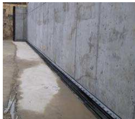
Klemmkonstruktion mit einem Sika® Klemmprofil Tricomer DA 320 KI
