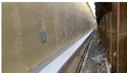
Sikadur-Combiflex® TF Abklebung der Sohle-Wand-Fuge mit Bodenplattenüberstand
