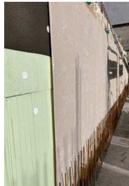
Verlegung auf Perimeterdämmung in einhäutig geschaltem Bereichen
