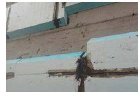
Verzahnungen und Rücksprünge in einhäufigen Bereichen im 45°-Winkel ausbilden
