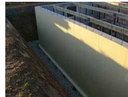
Visuelle Kontrolle und Qualitätssicherung vor dem Verahren und Verfüllen der Baugrube
