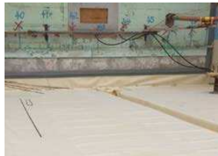
Anschluss an ein Bestandsgebäude mit einem Sikadur-Combiflex® TF Profil DFT 330/3 KFV
