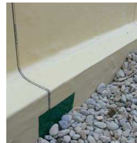
Fertig versiegelte T-Stöße
