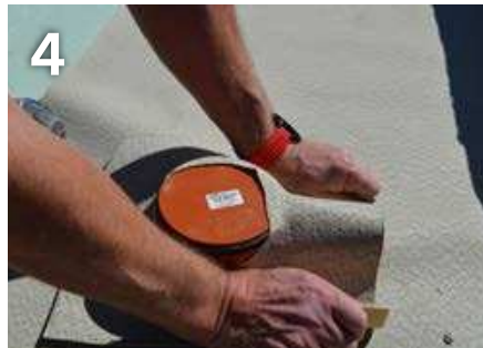
4 Erwärmte Bahn vorsichtig über die Rohrdurchführung ziehen.
