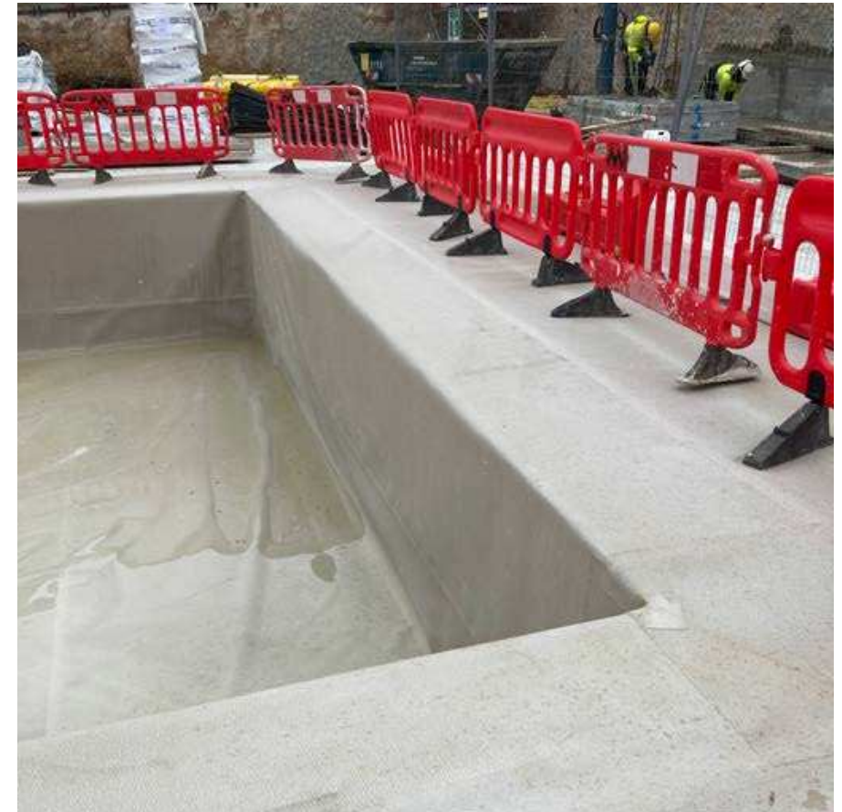
Eckbereiche bei der Ausbildung einer Aufzugsunterfahrt
