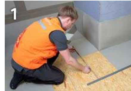
1 Einschneiden und Bahn einlegen
