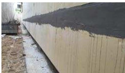
Sikadur-Combiflex® TF Abklebung der Sohle-Wand-Fuge ohne Bodenplattenüberstand
