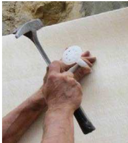
Befestigung mit Dämmstoffdübeln
