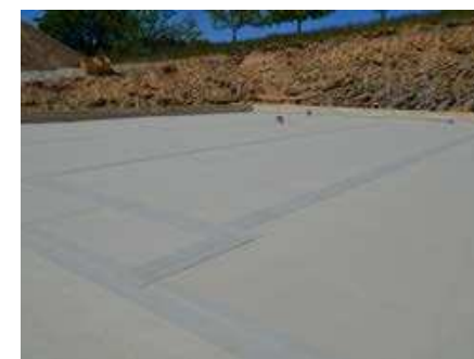
Verlegte Fläche mit Längs- und Quernähten, sowie T-Stößen.
