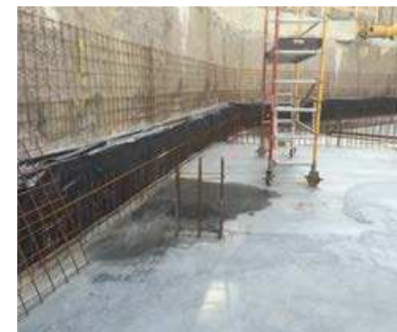
Geschützter Anschlussbereich nach der Betonage der Bodenplatte
