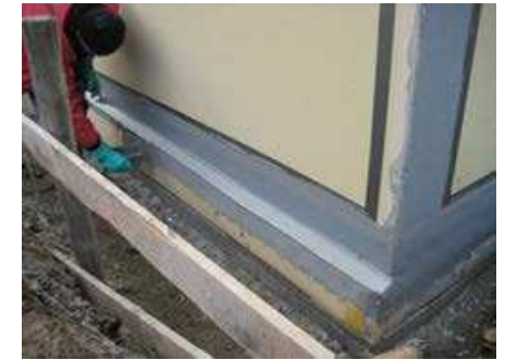
Applikation der Sikadur-Combiflex® TF Abklebung mit Anschluss an SikaProof®
