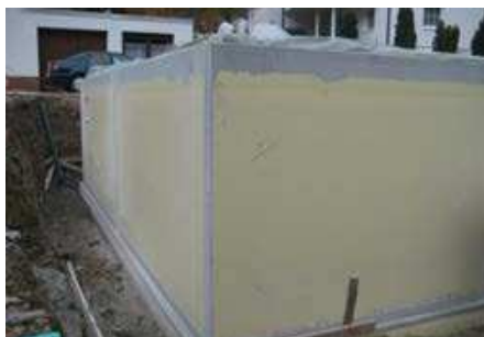
Stellen der Elementwände und Betonage des Kernbetons
