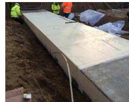
Applikation von SikaProof® P-12 im Deckenbereich
