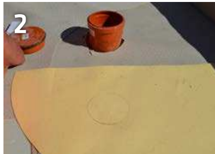
2 Passtück vorbereiten und mittig den Umfang der Rohrdurchführung anzeichnen.
