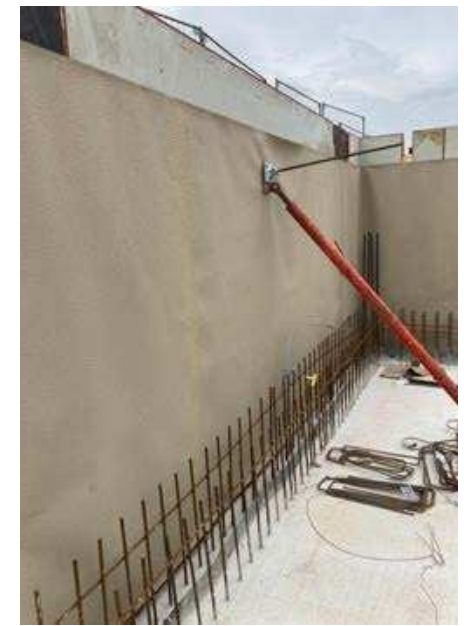
Verlegung auf Systemschalung in zweihäufig geschaltem Wandbereichen
