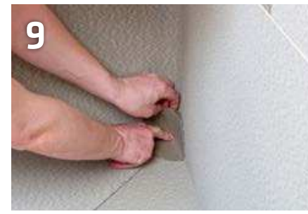
9 Faltenfrei im Eckbereich platzieren
