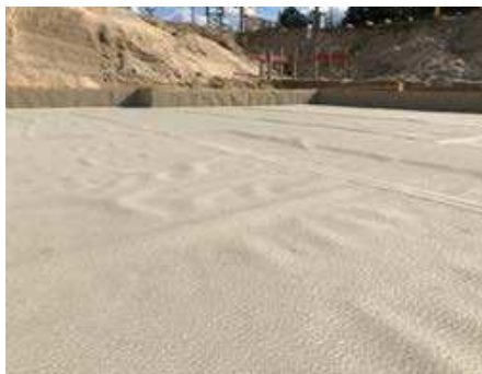
Wellenbildungen und Verwerfungen aufgrund Temperaturschwankungen sind werkstoffbedingt und stellen keinen Mangel dar.
