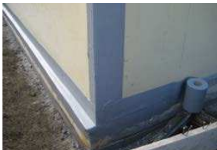
Abkleben der Fugen mit dem Sikadur-Combiflex® TF System
