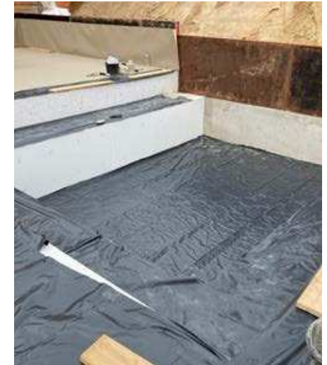
Verlegung auf PE-Folie in Bodenplattenbereich
