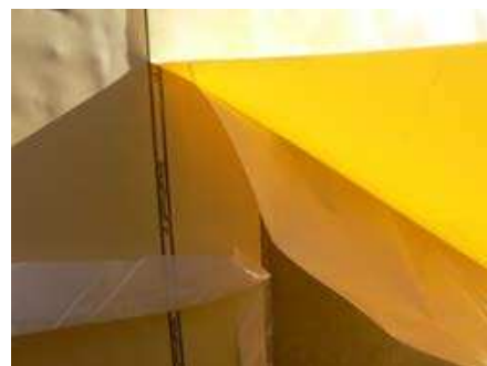
Zusätzlicher Kleberand am Längsstoß: Schutzliner vor dem Verkleben der überlappenden Bahn abziehen.
