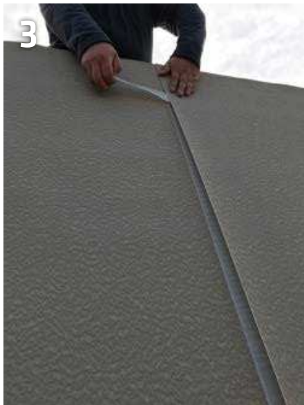
Abziehen des Schutzstreifens
