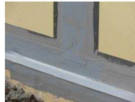
Applikation der Sikadur-Combiflex® TF Abklebung mit Anschluss an SikaProof®
