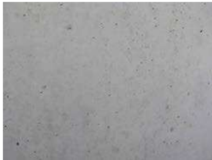
Oberfläche eines wasserundurchlässigen Betonbauteiles
