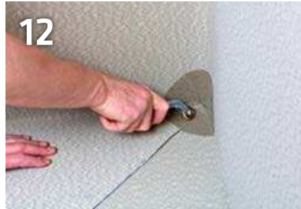
12 Mit geeignetem Roller im Eckbereich sorgfältig anrollen
