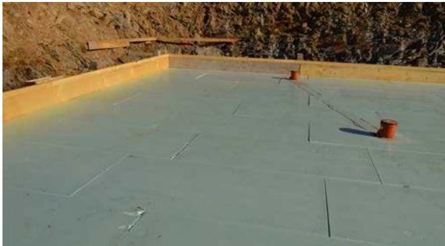
Optimal vorbereiteter Untergrund für die Verlegearbeiten aus Randschalung und Perimeterdämmung
