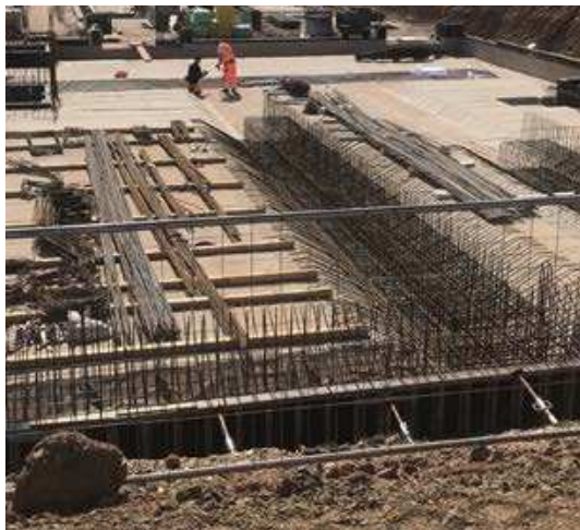
Bewehrungsarbeiten auf Flächen mit SikaProof® mit entsprechenden Schutzmaßnahmen
