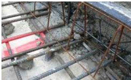
Beispiel eines Spacer-Auslaufschutzes, Quelle: www.trigoform.de
