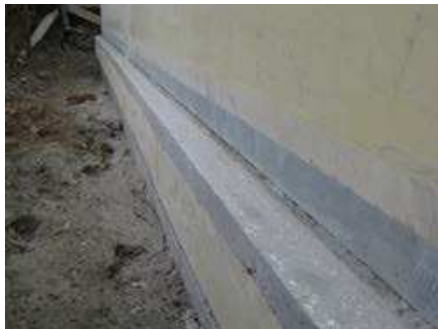
Beidseitig der Arbeitsfuge ausgebildete freie Betonrandzone
