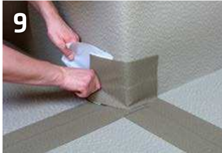
Zusätzlich Tape zur Abdeckung aufbringen
