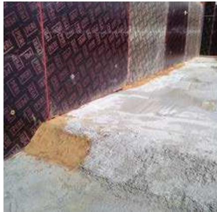
Auffüllen von Hohlstellen im Untergrund, z. B. mit Sand
