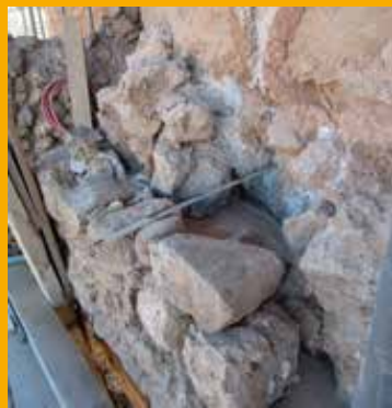
Mauerwerkssanierung mit Gipsmörtel am westlichen Iwan 2017 (Foto: Burkert)
