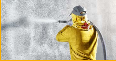
BETONSCHUTZ UND -INSTANDSETZUNG
