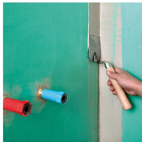
2a. Vor dem Ausführen der Wand-Bodenanschlüsse ausreichend viel Abdichtungsmaterial PCI Lastogum Dicht auftragen.
