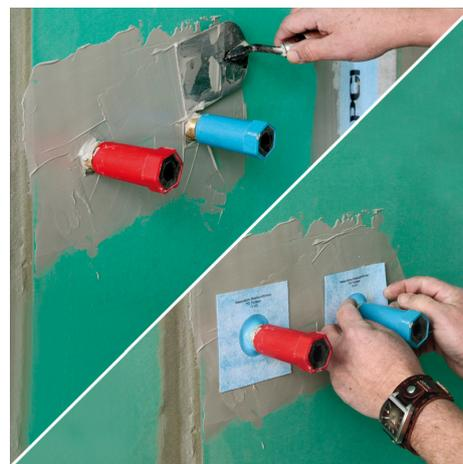
2c. Auch zum Abdichten der Wasserzuleitungen mit der Dichtmanschette PCI Pecitape 10 x 10 wird zunächst ausreichend viel Abdichtungsmaterial PCI Lastogum Dicht vorgelegt. 2d. PCI Pecitape 10 x 10 über den aus der Wand herausstehenden Rohrschluss stülpen und mit PCI Lastogum verkleben.
