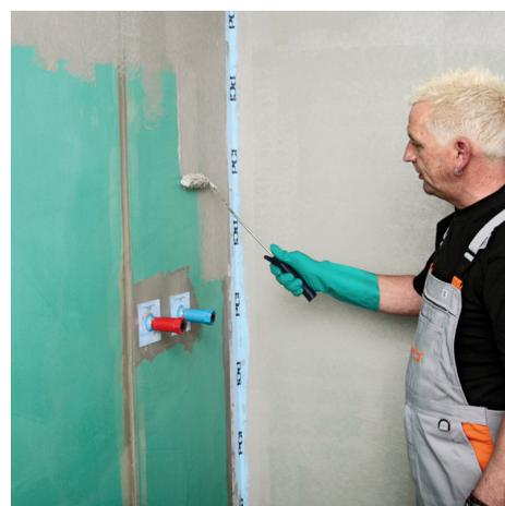
3. PCI Lastogum Dicht in zwei Arbeitsgängen dann flächendeckend auftragen.
