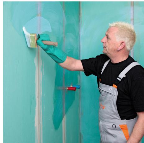
1. Grundierung PCI Gisogrund All-in-One flächendeckend auftragen.
