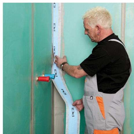
2b. Eck- und Anschlussfugen abdichten. Nachfolgend das Dichtband PCI Pecitape mit leichtem Druck in das noch frische PCI Lastogum Dicht einbetten. Innenecken einlegen.
