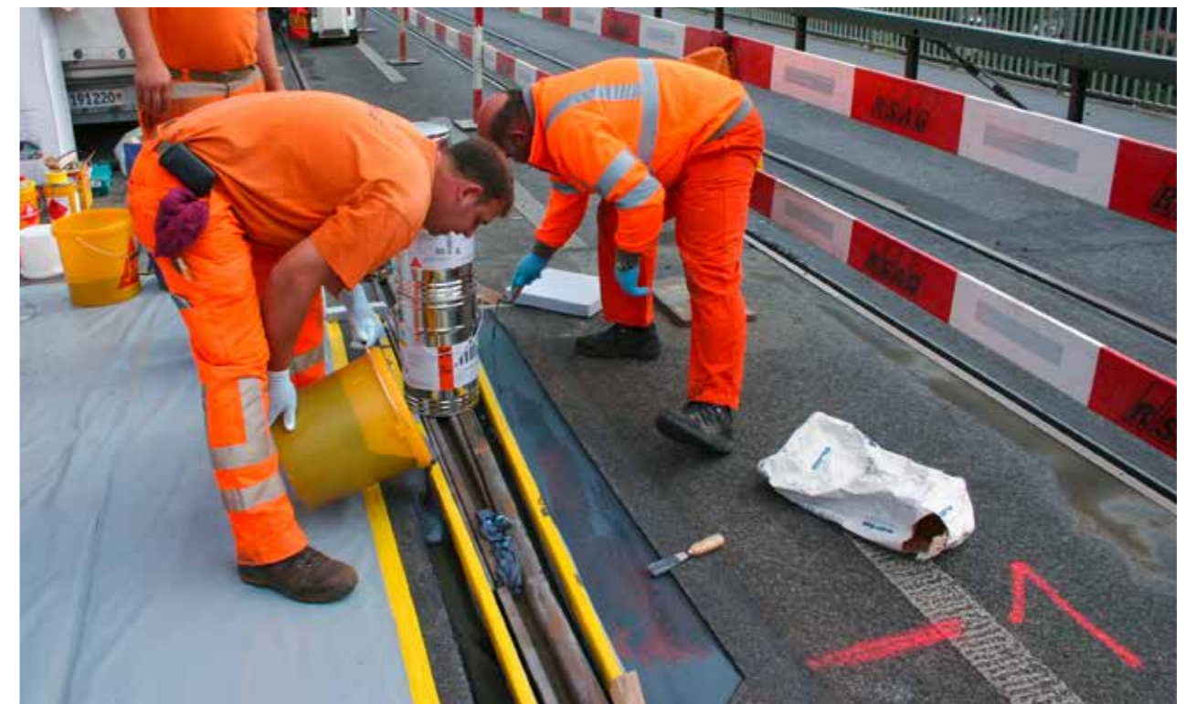
Kontinuierlicher Verguss von Rillenschienen
