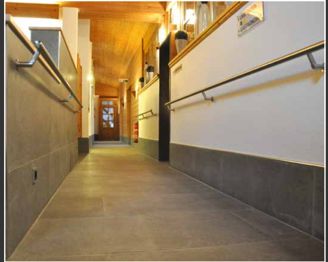
Flurbereich zu den Ruheräumen im Erdgeschoss nach Abschluss der Sanierungsarbeiten.
