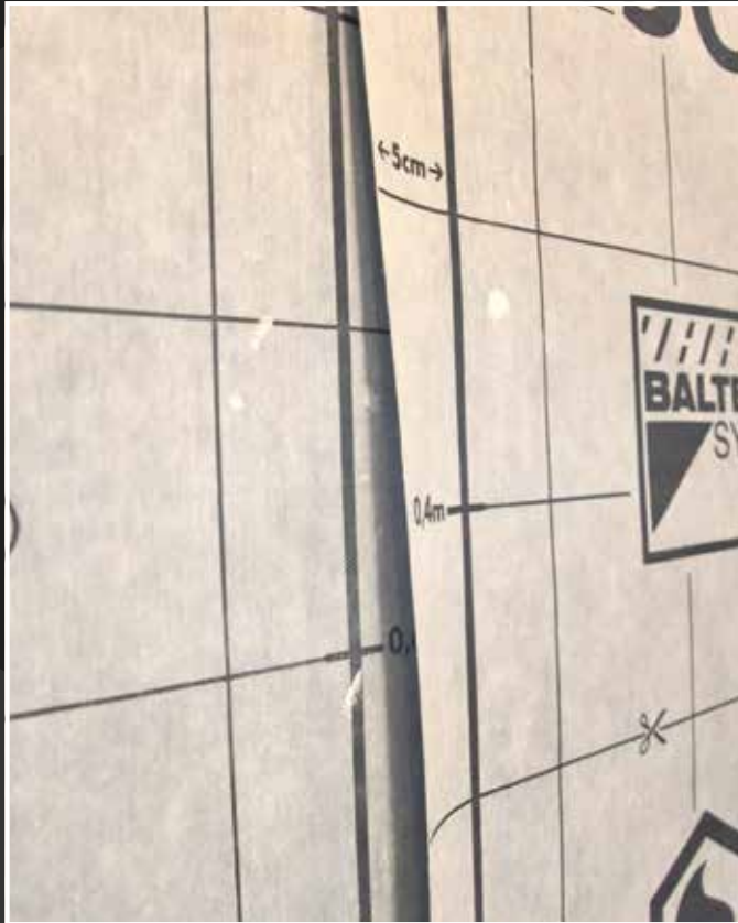
Detailansicht der Überlappungsbereiche.
