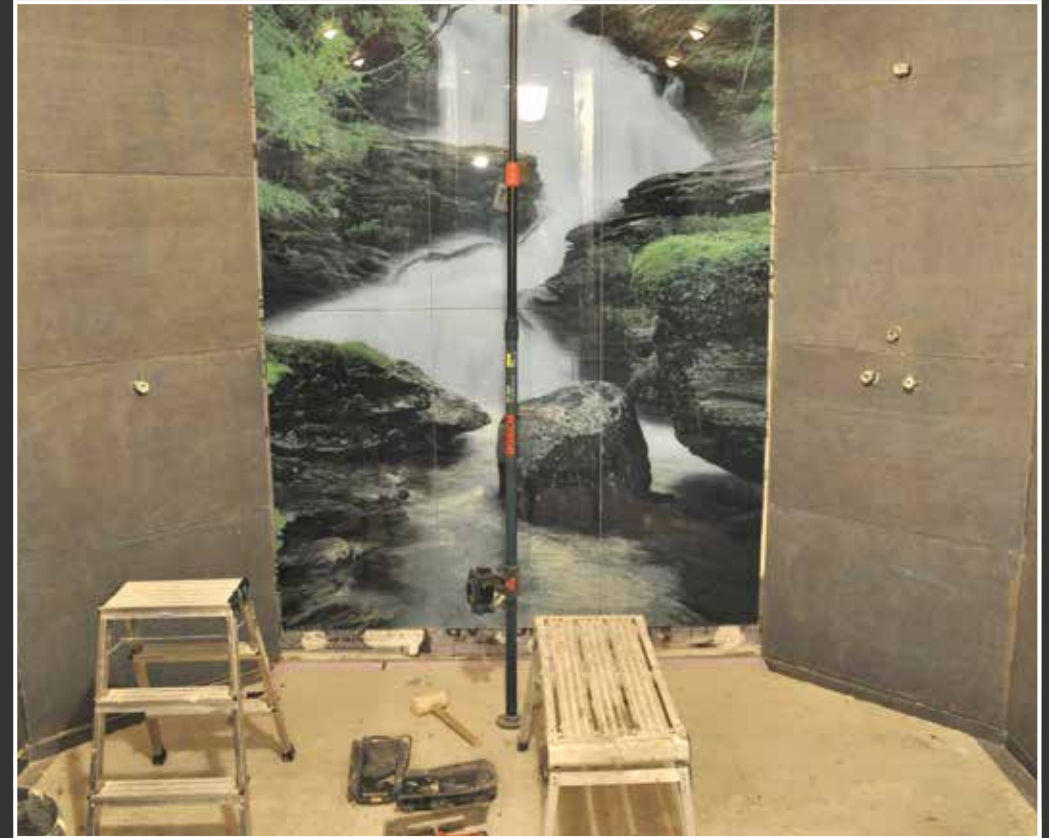
Duschbereich Erdgeschoss im Renovierungsprozess.
