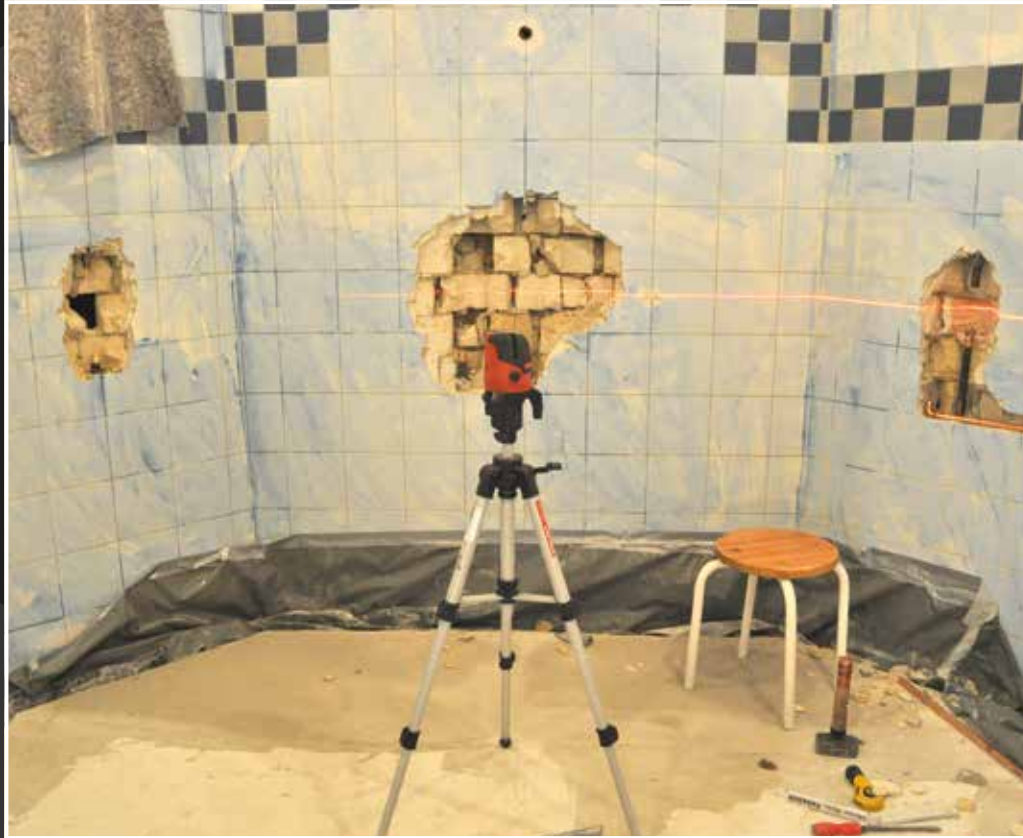
Alter verbundfähiger Fliesenbelag mit SCHÖNOX SHP grundiert. Ausbruchstellen mit SCHÖNOX PL PLUS reprofiliert.
