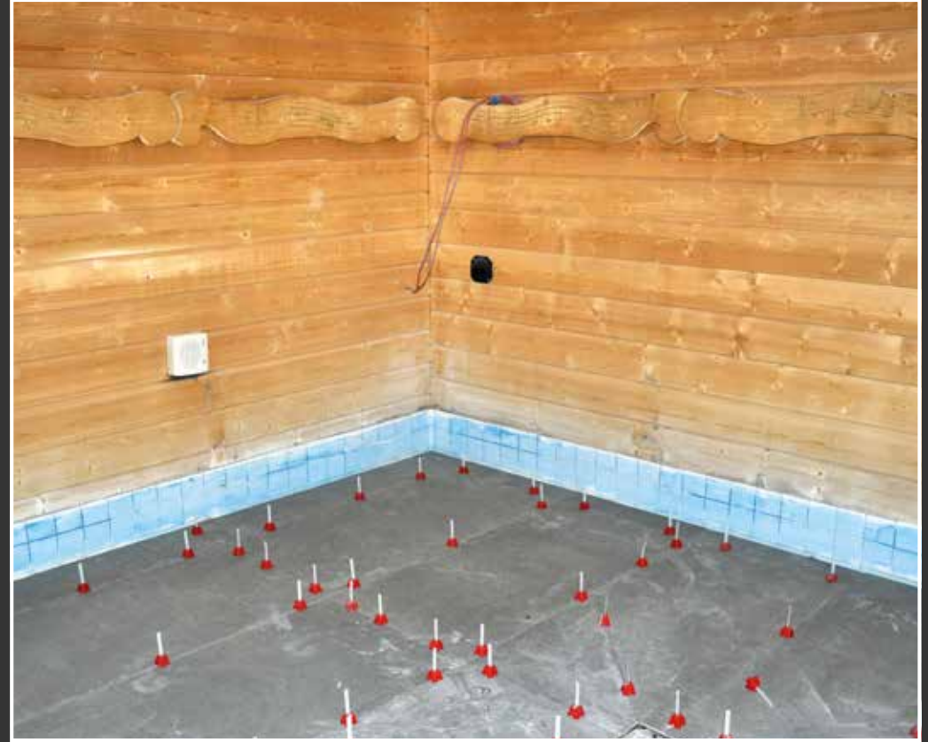
Verlegung der Großformate mit SCHÖNOX Q12.
