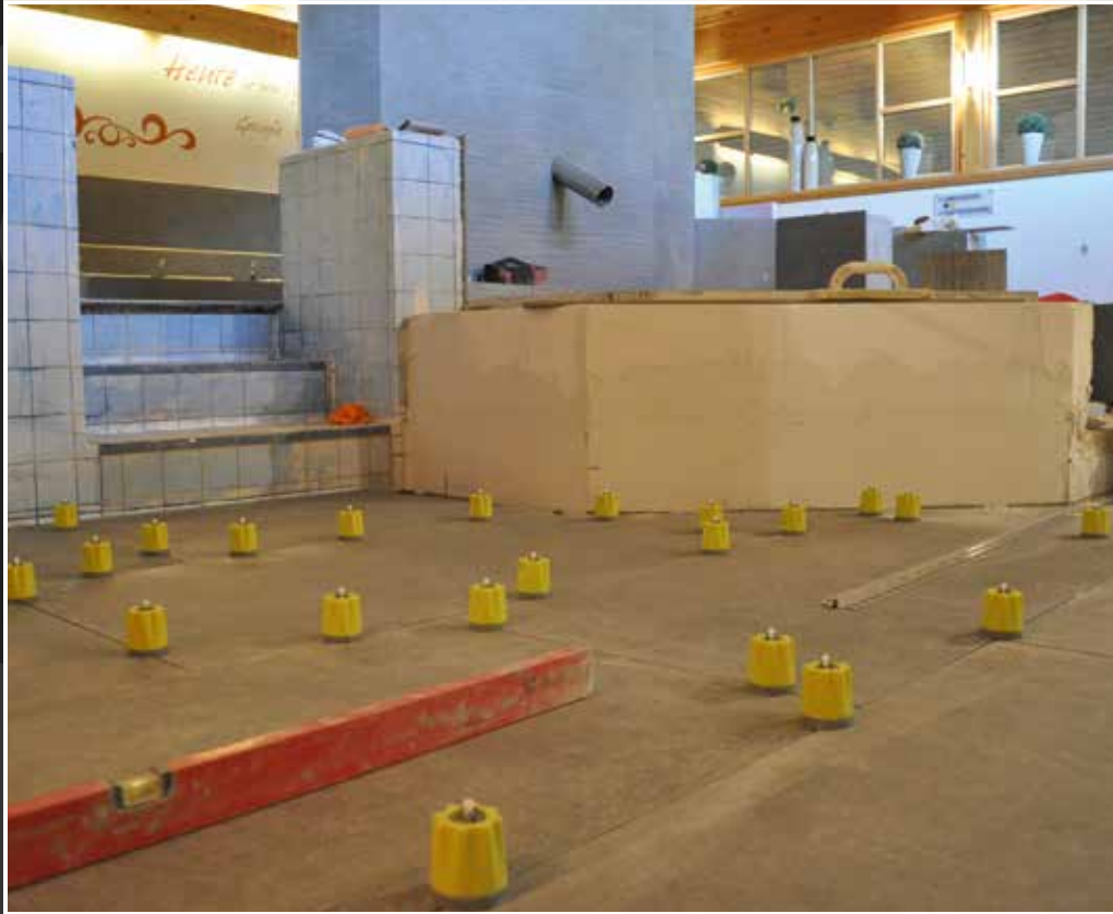
Detailaufnahmen im Umgangsbereich des Tauchbeckens mit Nivelliervorrichtungen für großformatige Fliesen.
