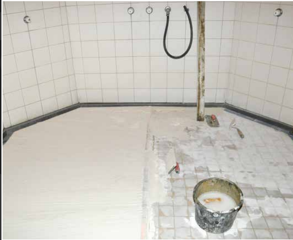
Duschbereich Erdgeschoss vor der Sanierung.
