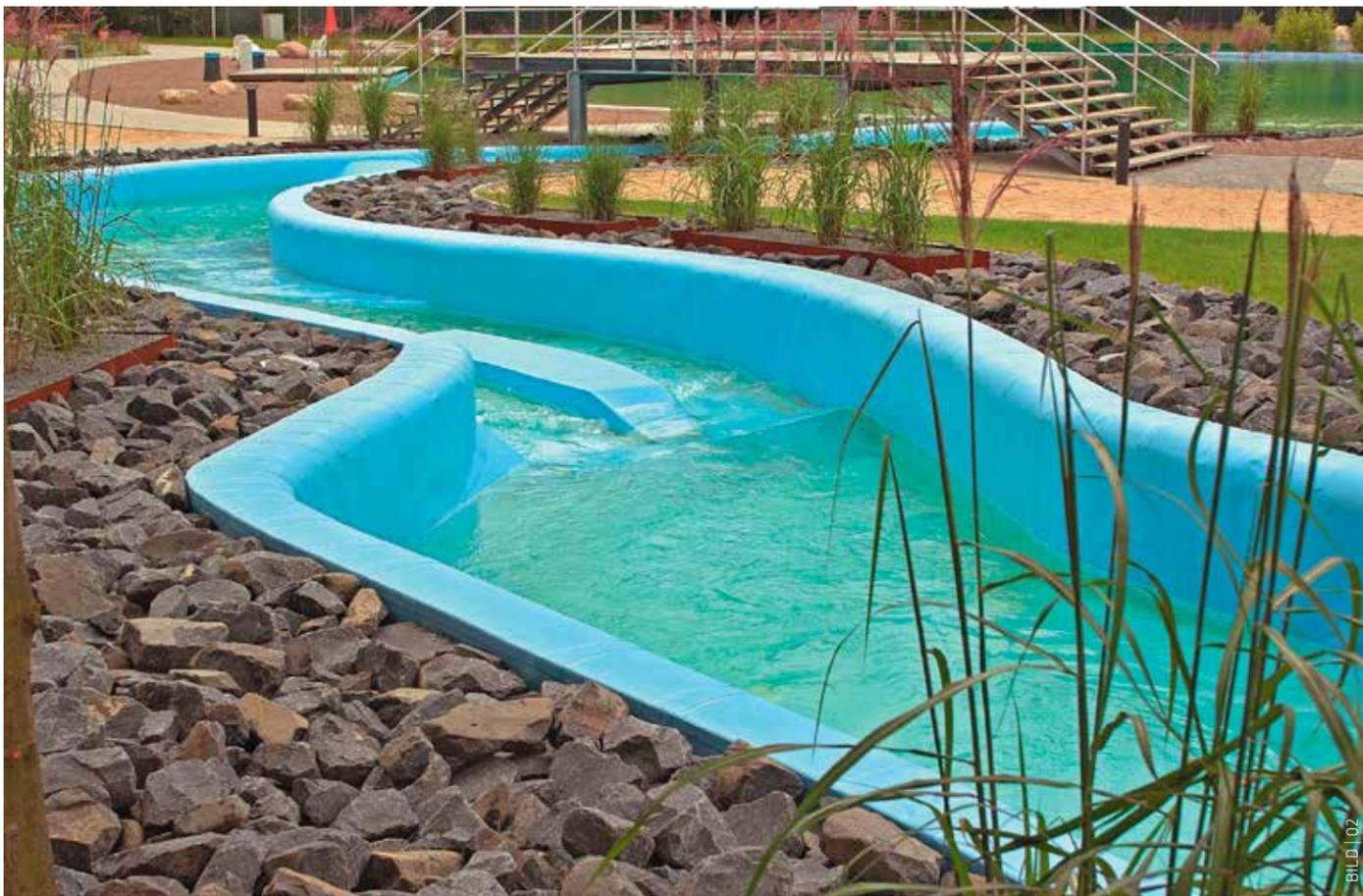
Das neu gestaltete Becken wurde mit der FPO-Kunststoffdichtungsbahn Sikaplan WT 5300-15 C mit Glasvlieseinlage aus dem Hause Sika Deutschland GmbH ausgestattet. Speziell für dieses Bauvorhaben wurde die Dichtungsbahn erstmals in azurblauer Farbe hergestellt, um den Lagunencharakter zu unterstreichen.
