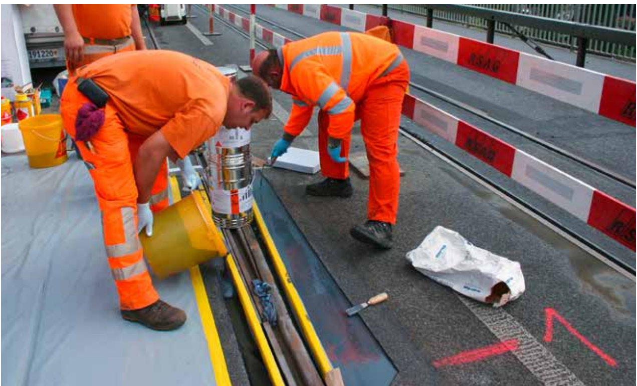
Kontinuierlicher Verguss von Rillenschienen
