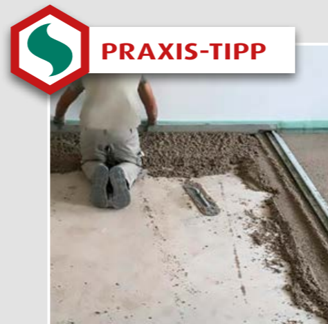
5 Praxis-Tipp: Das Abziehen über Lehren erleichtert das Einhalten der gewünschten Höhen.
