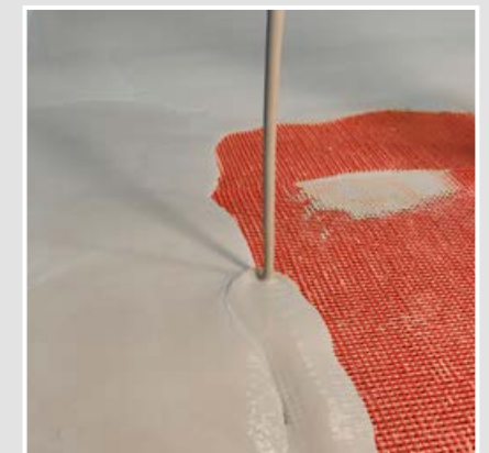
10 Nach ca. 30 Minuten SCHÖNOX HS 50 in einer Mindestschichtdicke von ca. 6 mm über dem Gewebe auftragen.
