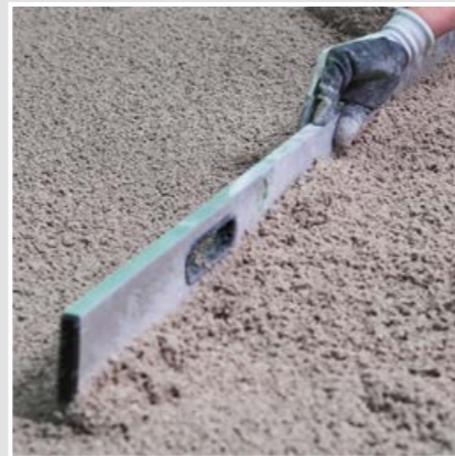
4 Den Leichtestrichmörtel in der Fläche mit einer Richtlatte planeben abziehen.
