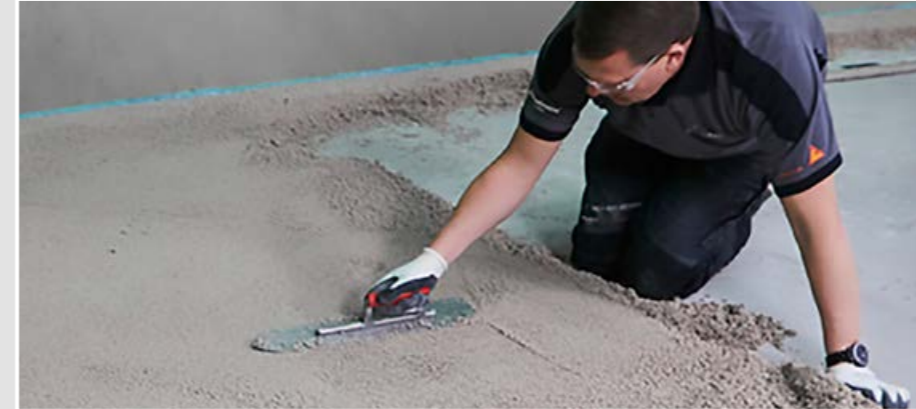
6 Die Oberfläche nach ca. 5-10 Minuten mit dem Glättschwert oder einer Kelle gut verdichten.
