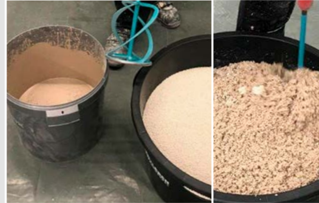
2 Das Spezialbindemittel SCHÖNOX LEB mit 3,25L kaltem, sauberem Wasser ca. 60 Sekunden anmischen. Leichtfüllstoff SCHÖNOX LEF bei laufendem Rührwerk zugeben und erneut ca. 120 Sekunden mischen.
