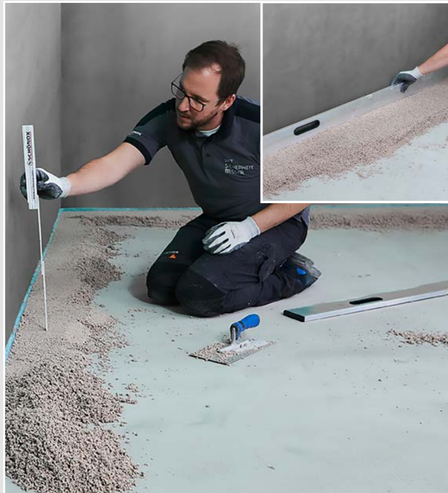
3 Den SCHÖNOX LEICHESTRICH im Randbereich in der gewünschten Schichtdicke vorlegen. Die Kontrolle der genauen Höhen kann unter zur Hilfenahme eines Lasers oder mittels Höhenmesspunkten erfolgen.
