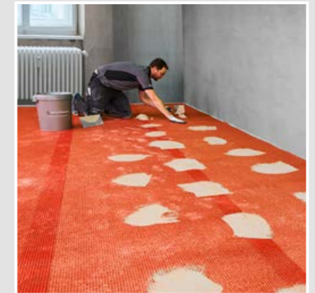
9 Die einzelnen Bahnen mind. 5 cm überlappen und mit SCHÖNOX HS 40 S punktuell auf dem Leichtestrich fixieren.
