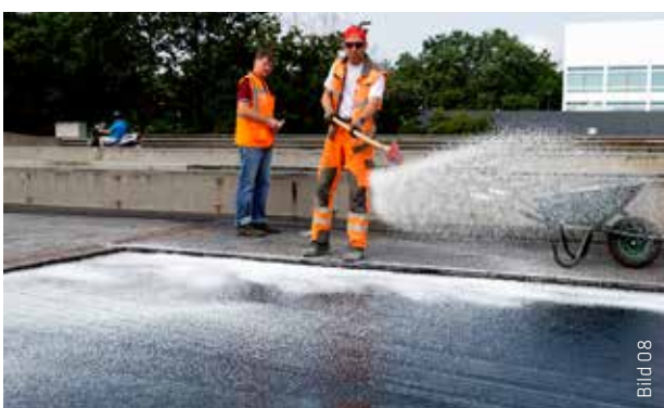
Lose gestreut, sorgte Sikalastic®-827 HT für einen optimalen Haftverbund zwischen der HANV- und der schützenden Gussasphaltschicht.
