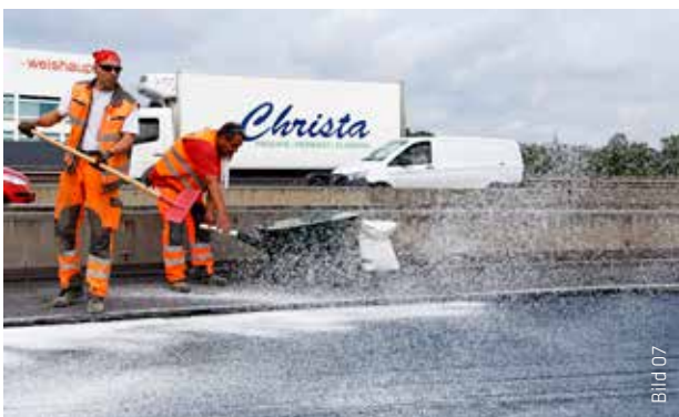
Lose gestreut, sorgte Sikalastic®-827 HT für einen optimalen Haftverbund zwischen der HANV- und der schützenden Gussasphaltschicht.
