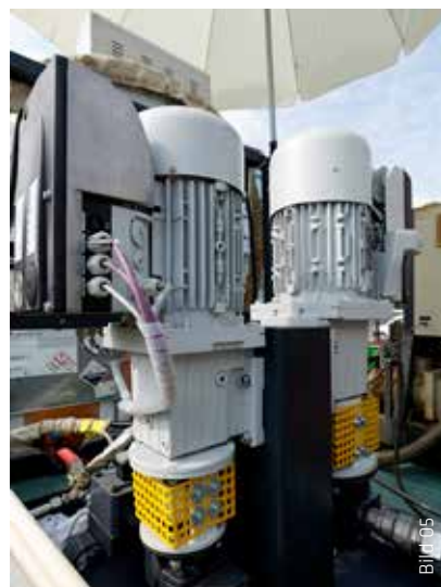
Spezielle Pumpen förderten den elastischen, dünnflüssigen Dichtstoff Sika Ergodur®-600 auf den Bodenbelag.
