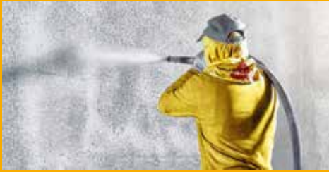
BETONSCHUTZ UND INSTANDHALTUNG
