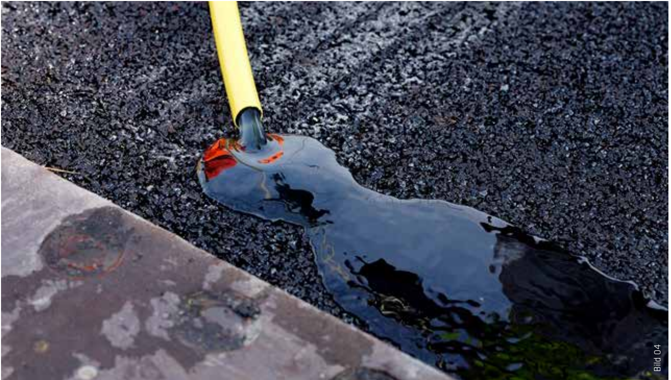
Im HANV-Verfahren (Hohlraumreiches Asphaltträgergestüt mit nachträglicher Verfüllung) sorgte Sika Ergodur®-600 für die Brückenabdichtung.
