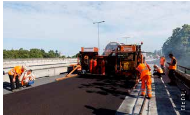
Mit einer abschließenden Schutzschicht aus Gussasphalt war die rechte Fahrbahnhälfte wieder vollständig saniert.
