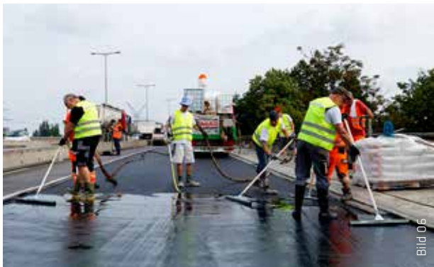
Mit Gummischiebern ließ sich der Dichtstoff Sika Ergodur®-600 optimal in das Asphaltträgergerüst einarbeiten.
