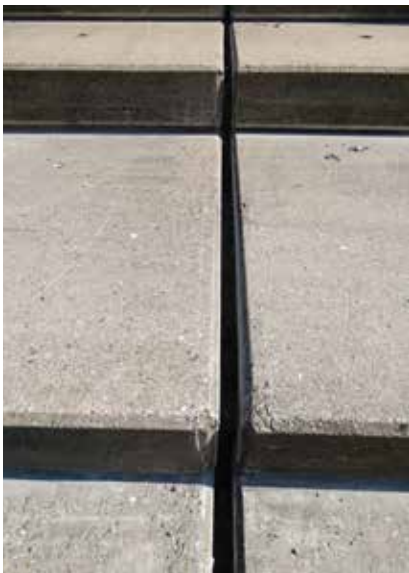
In einem ersten Arbeitsschritt wurden die Fugen gereinigt. Mit zwei bis vier Zentimetern ging die Fugenbreite über das Standardmaß hinaus.
