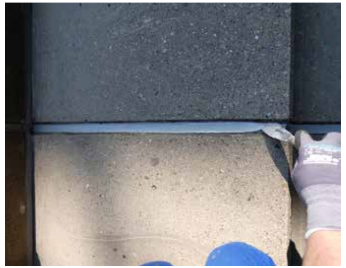
Beim Glätten und dem Angleichen des frisch applizierten Dichtstoffs an die Fugenränder wurde das neutrale Sika® Abglättmittel N verwendet.
