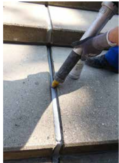
Die Verfugung mit Sikaflex® PRO-3 in Betongrau erfolgte mit akkubetriebenen Auspresspistolen.
