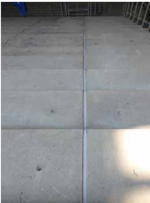
Sikaflex® PRO-3 verfügt über eine geringe Kerbempfindlichkeit und einen hohen Weiterreißwiderstand. Daher eignet sich das Produkt besonders für den Einsatz bei Zuschauertribünen.
