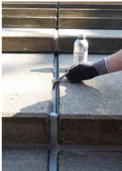
Die Grundierung der Fugenflanken mit dem Sika® Primer-3 N erfolgte händisch.
