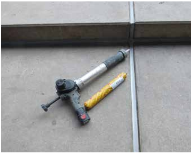
Der PU-Hochleistungsdichtstoff Sikaflex®-PRO 3 wurde in Schlauchbeuteln angeliefert (600 ml).
