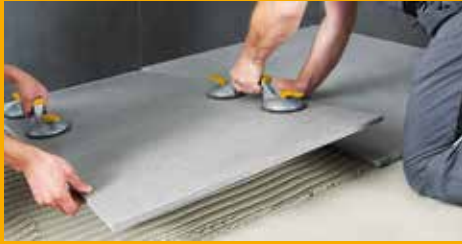
FLIESEN-, WAND- UND FUSSBODENTECHNIK
