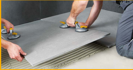
FLIESEN-, WAND- UND FUSSBODENTECHNIK
