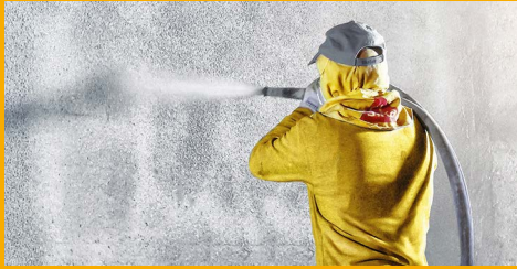
BETONSCHUTZ UND INSTANDHALTUNG
