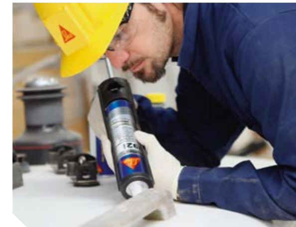
Verklebung der Scheuerleiste mit Sikaflex®-292i
