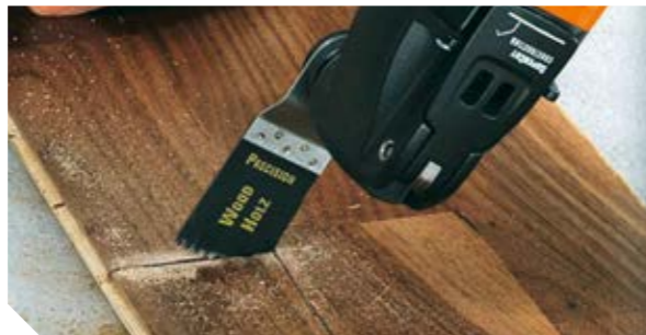
Trennen der Leisten mit einer Vibrationssäge
