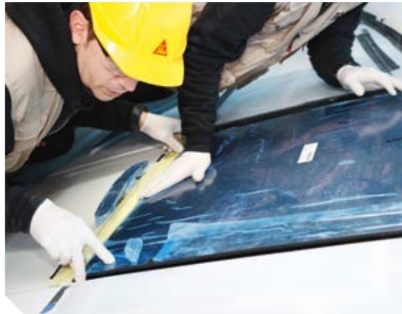
Auftrag von Sikaflex®-296
