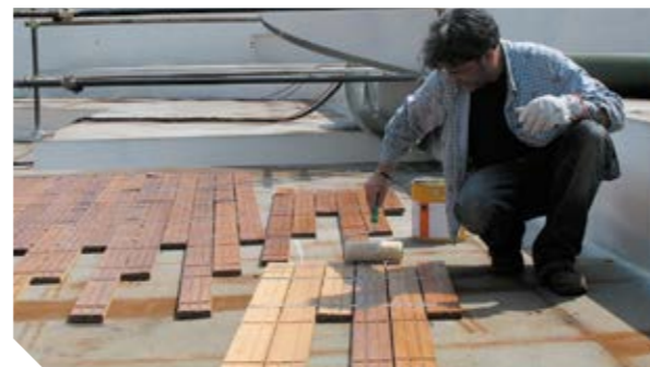
Auftrag von Sika® MultiPrimer Marine mit einer Walze auf ein Teakdeck (Rückseite)
