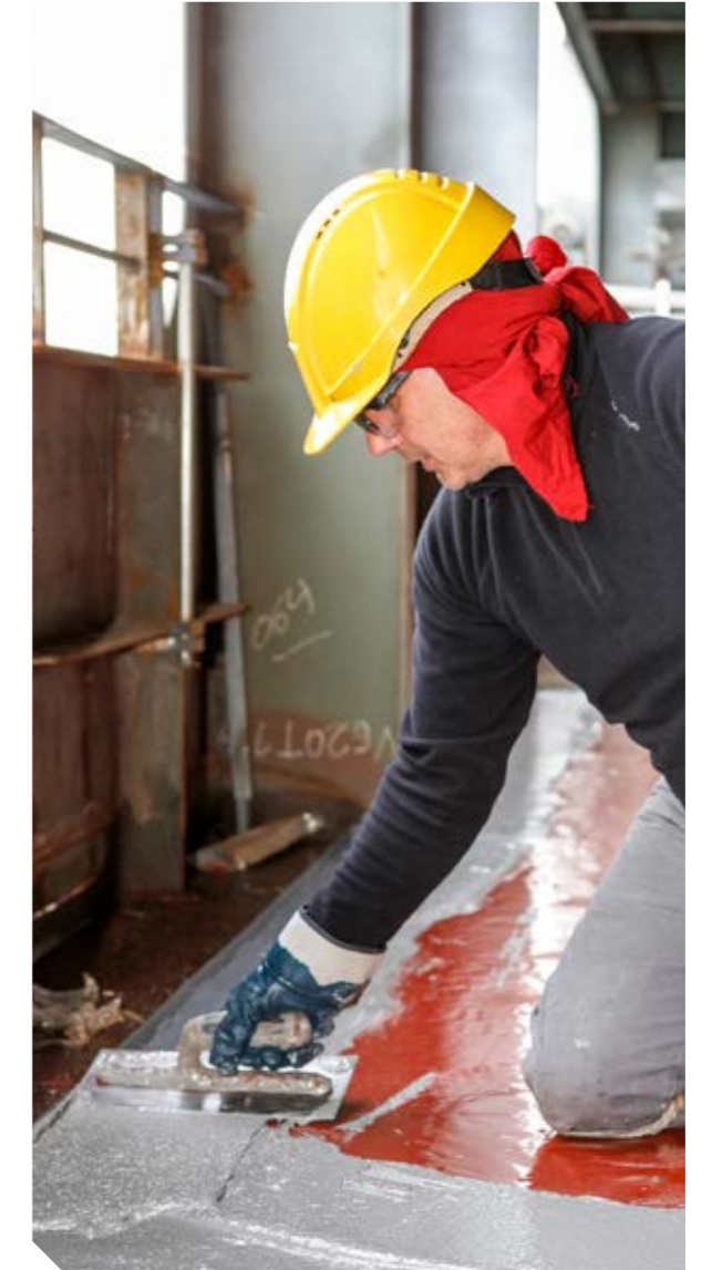
Verteilen von SikaTransfloor-352 SL mit einer Kelle
