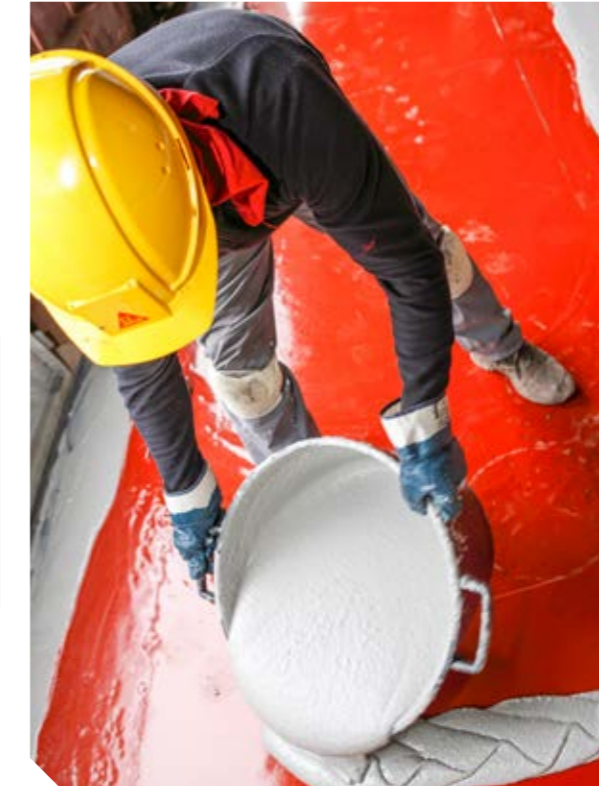
Ausgießen des fertig angerührten SikaTransfloor®-352 SL auf das Deck
