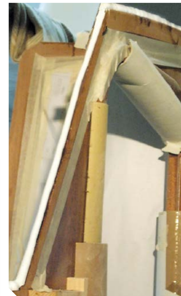
Sikaflex®-292i auf einer Leichtbauplatte vor der Verklebung
