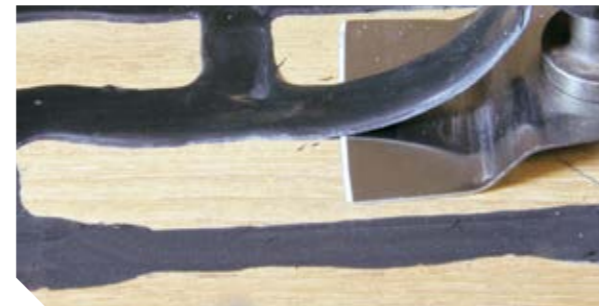
Entfernen von überschüssigem 290 DC PRO mit einem oszillierenden Schaber
