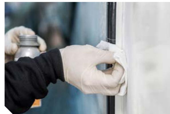
Vorbehandlung des Keramiksiebdruckrands mit Sika Aktivator-100
