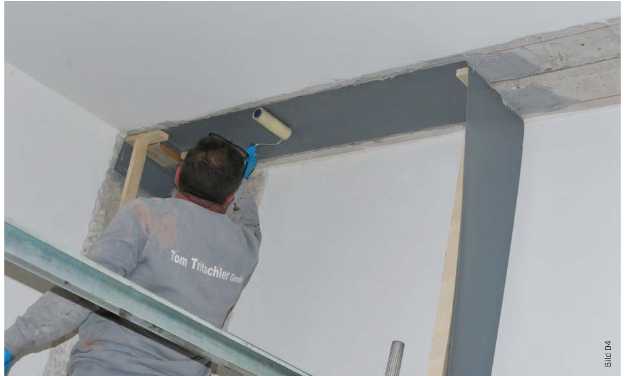
Nachträgliche Abdichtung der zu sanierenden Bewegungsfuge mit dem zwei Millimeter Dichtstreifen des Sikadur-Combiflex® TF Systems.
