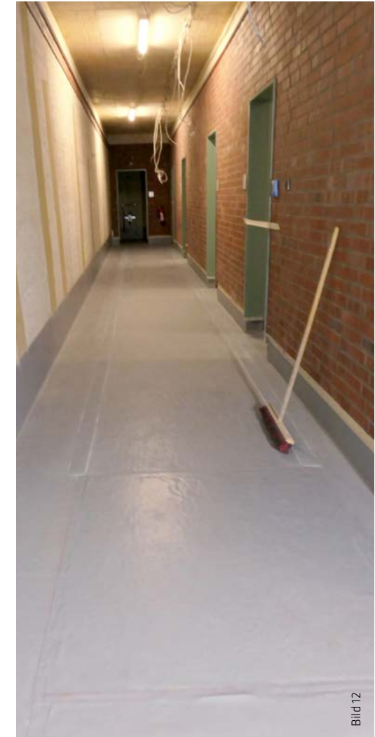
Flächige Abdichtung in den Nebenräumen und Fluren.
