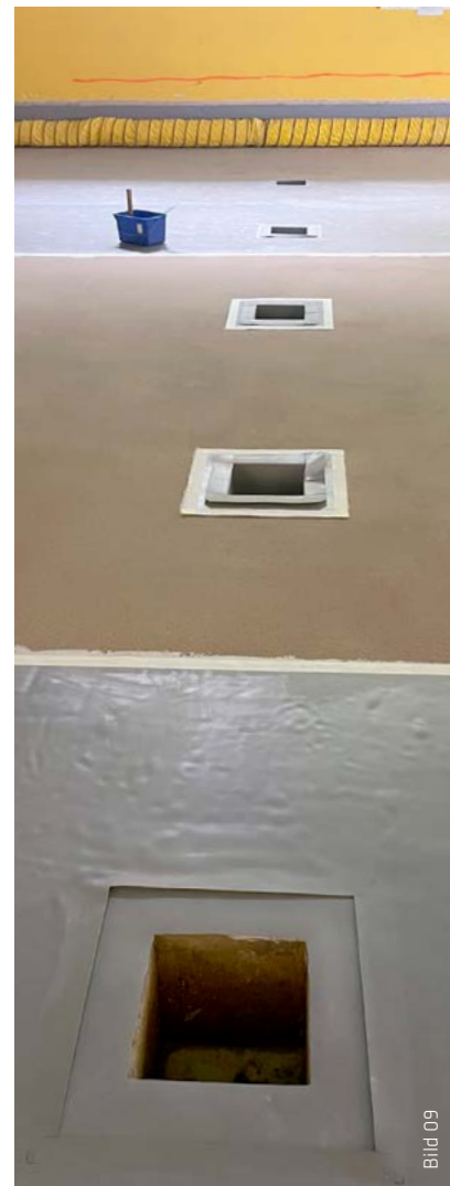
Abklebung der Aufkantung zu aufgehenden Bauteilen.
