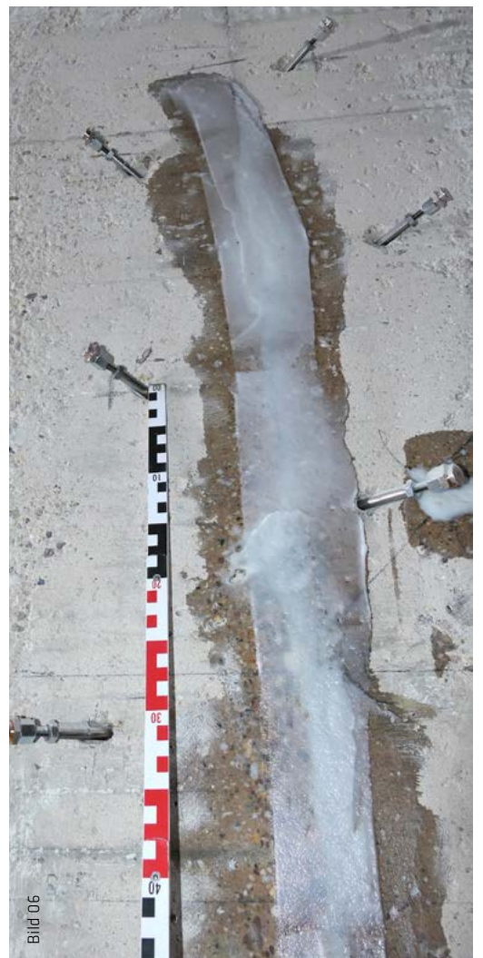
Riss- und Flächeninjektionen mit SikalInject®-201 DE auf PU-Basis.
