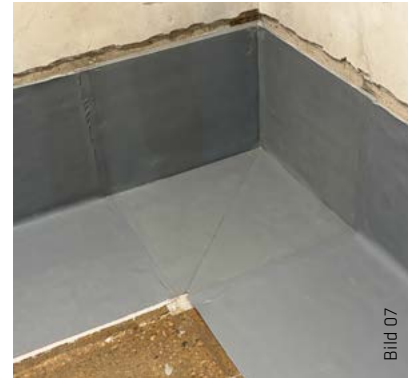
Abklebung der Aufkantung zu aufgehenden Bauteilen.
