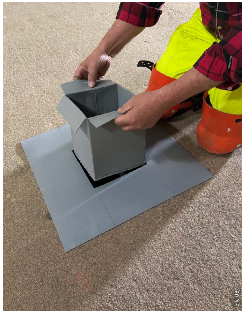
Herstellen von Formteilen für die Bodeneinstandshülsen.
