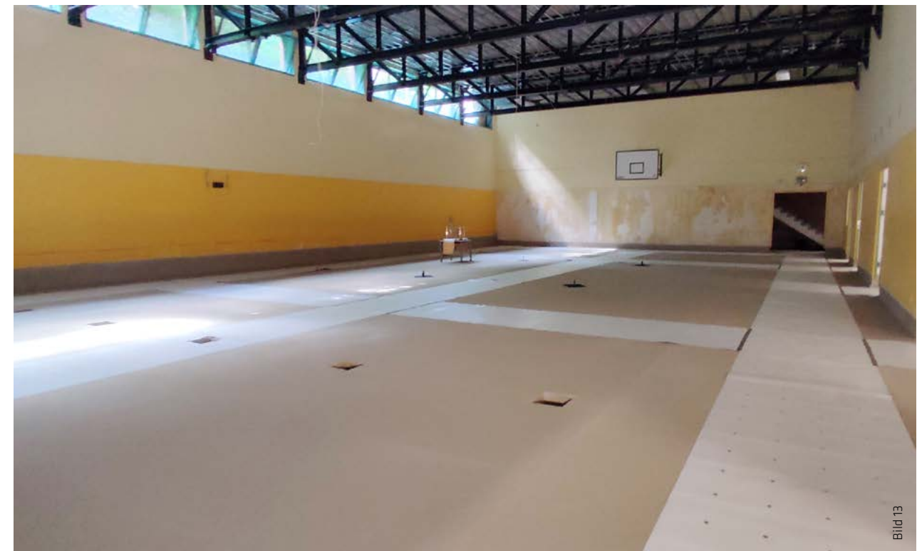
Fertiggestellte Sikadur-Combiflex® TF Abklebung als druckwasserdichte Innenwanne mit abgesandeten Kleberdeckauftrag.
