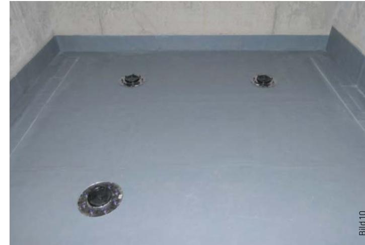
Eindichten von Bodenabläufen mittels Flanschsystemen.
