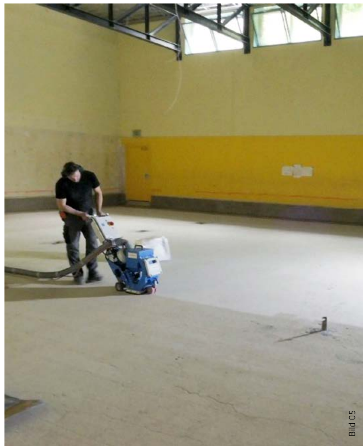
Vorbereiten der Flächen durch Kugelstrahlen.
