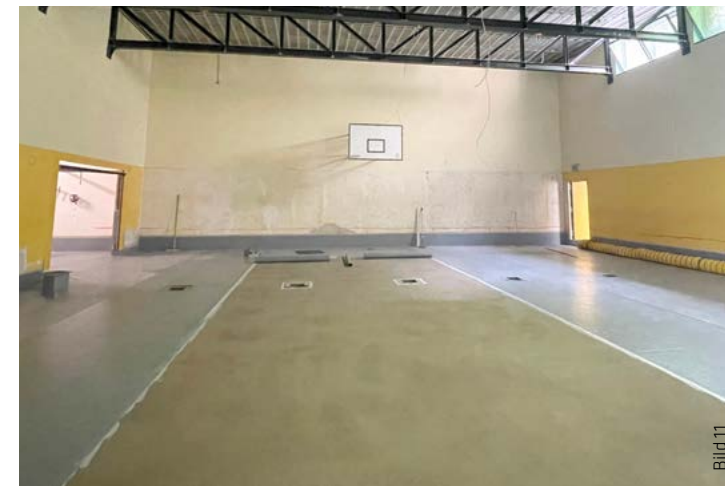
Flächige Abklebung mit Sikadur-Combiflex® TF Dichtstreifen in 200 Zentimeter Breite.
