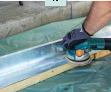
Traufblech: Anschleifen/Reinigen mit Sikalastic® Rapid Reiniger
