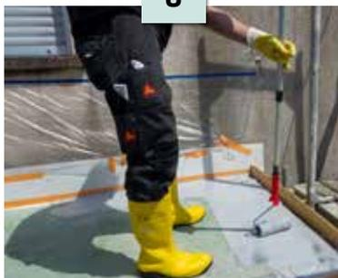
Applizierung der zementgebundenen Haftbrücke SikaScreed®-10 BB
