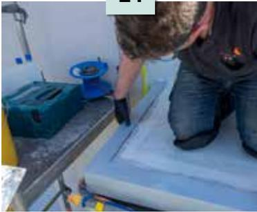
Traufblech mit dem PMMA Spachtel als Kleber lagesicher fixieren
