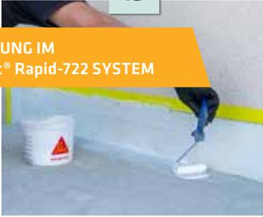
Applizierung Sikalastic® Rapid Primer Beton am Wandanschluss und in der Fläche
