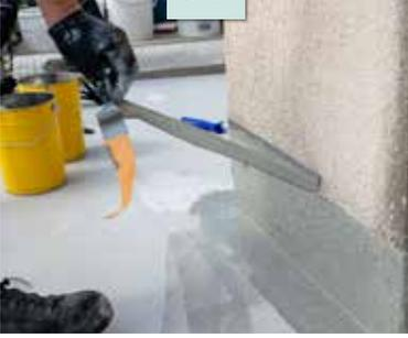
Abklebungen entfernen bevor die Aushärtung abgeschlossen ist
