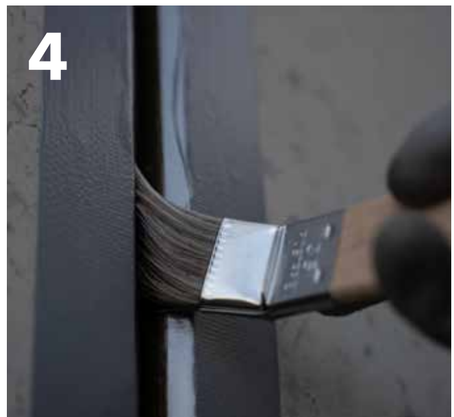
4 Fuge bei Bedarf abkleben und Fugenflanken mit Sika® Primer-115 vorbehandeln. Eine Ablüftzeit von mindestens 30 Minuten ist einzuhalten.
