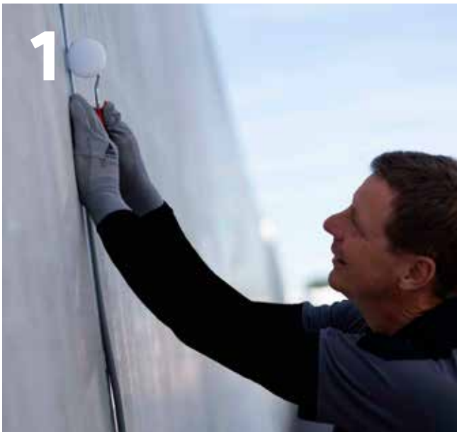
1 Fugenflanken reinigen und passende geschlossenzellige PE-Rundschnur einbringen.
