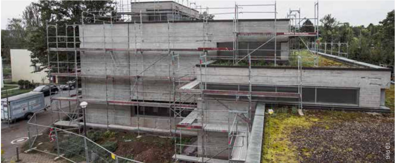
Die Steigkirche in Stuttgart-Bad Cannstatt zu Beginn der Sanierung der Sichtbeton-Fassade.
