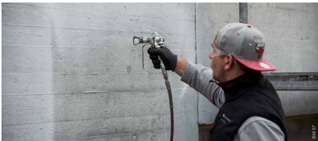
Die Schutzbeschichtung Sikagard®-674 Lasur W wurde unter Beimischung der Farblasur Sikagard®-675 W ElastoColor wo möglich Airless gespritzt.
