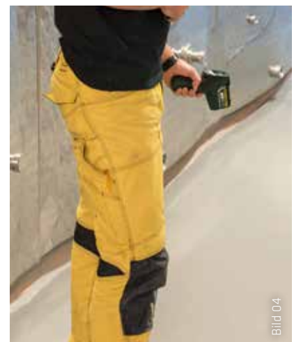
Zur Sicherstellung der optimalen Umgebungsbedingungen bei der Verarbeitung werden Bodentemperatur, Umgebungstemperatur und Luftfeuchtigkeit gemessen.
