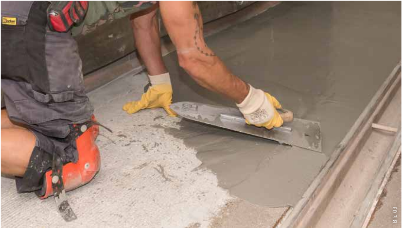
Auf dem vorbereiteten Untergrund erfolgte im ersten Arbeitsgang eine Kratzspachtelung mit Sikafloor®-21 PurCem.
