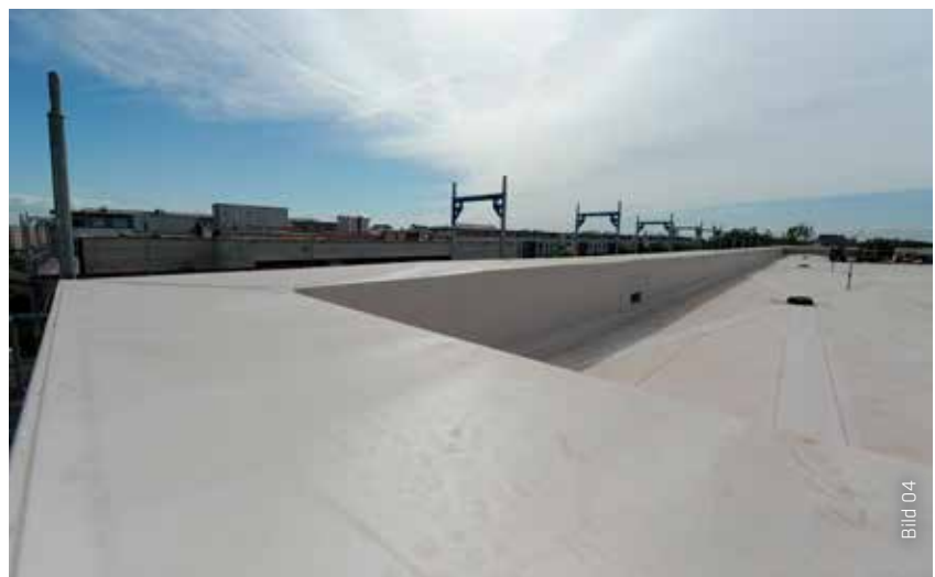
Im Attikabereich wurden Verbundbleche als luftdichter Anschluss angebracht.
