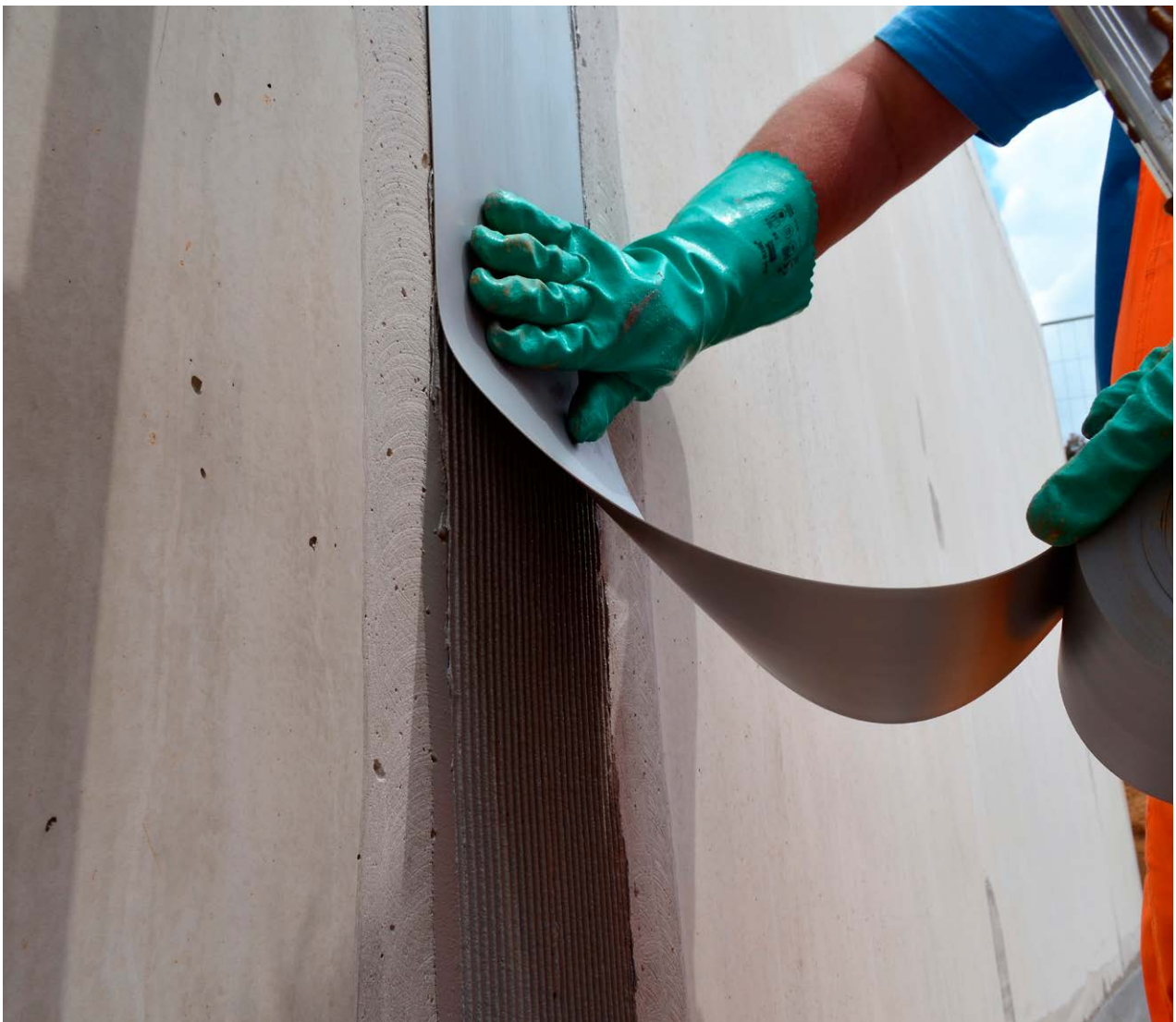
Sikadur-Combiflex® TF System: Dehnfugenausbildung
