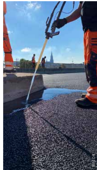
Das niedrigviskose Harz wird durch Schläuche gefördert flutend auf die Fläche aufgebracht und gleichmäßig mit dem Gummischieber verteilt. Wichtig ist für diese Arbeiten eine trockene Witterungslage.
