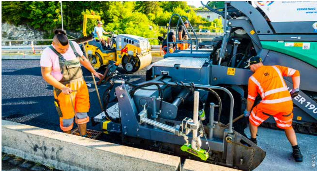
Mit der Walze wurde das Asphalttraggerüst ohne Vibration angedrückt, um die zur Verfüllung mit dem Sika Ergodur®-1000 HANV benötigten Hohlräume nicht zu zerstören.
