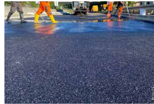
Die aus den Hohlräumen des ATG entweichende Luft wird in Form von Blasen sichtbar, solange muss die Flüssigkeit mit dem Schieber eingearbeitet werden.
