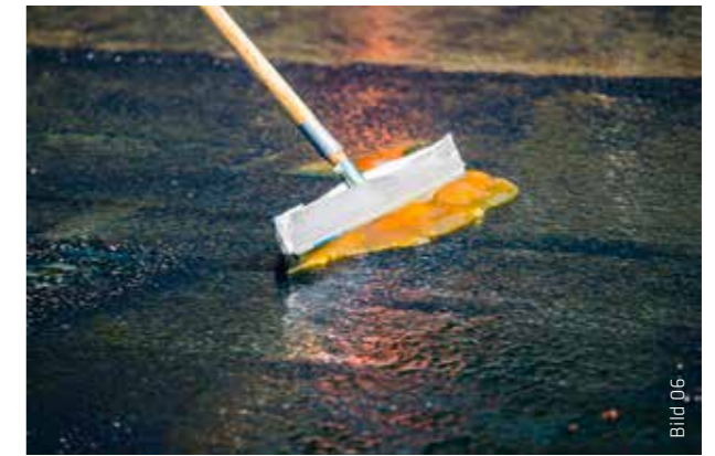
Nach kurzer Zeit sind keine Blasen mehr zu sehen. Das Sika Ergodur®-1000 HANV wechselt zu einer honigartigen Masse und erhärtet in den Hohlräumen des ATG.
