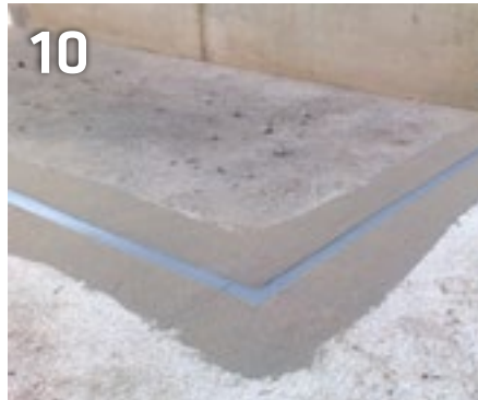
Abgesandetes Kleberbett zur späteren Aufnahme anzuschließender Beschichtungen
