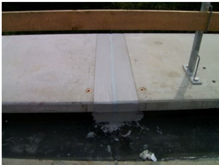
Abklebung einer Dehnfuge mit einem LFT-Fugenbandprofil
