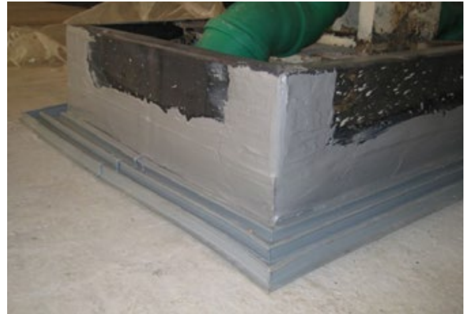
Anschluss einer neuen Bodenplatte an Stahlstützen durch Abdichtung mit einem DFT-Fugenbandprofil
