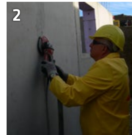
Untergrundvorbereitung durch Anschleifen mit Topfscheibe
