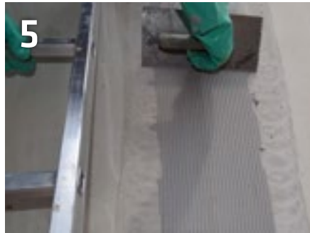
Durchgehender Grundauftrag des Systemklebers mit einer 4 mm Zahnkelle im Bereich von Arbeits- oder Elementwandfugen
