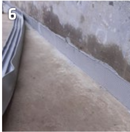
Einlegen des DFT-Profils in das Kleberbett
