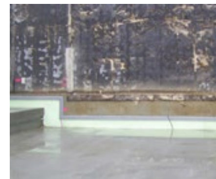
Abdichtung einer Anschlussfuge an ein Bestandsbauwerk mittels FAT130/3 KF Profil
