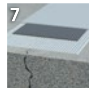
Abdichtung von Rissen
