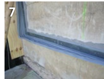
Fixieren des DFT-Fugenbandprofils mit einer Lochblechschiene
