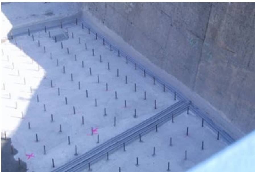
Fugenbandprofile DFT 330/3 in Kombination mit DFT 330/3KI bei der Sanierung eines Bestandsbauwerkes
