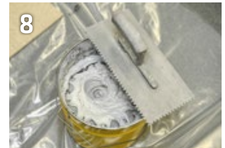
Weitere 1 Minute rühren und kontrollieren, dass die Masse vollständig schlierenfrei ist. Danach ist der Kleber gebrauchsfertig und sollte schnellstmöglich verarbeitet werden.
