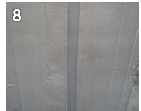
Sauber hergestellter Dehnbereich der Dehnfugenausbildung
