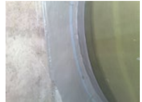
Abdichtung einer GFK-Rohrdurchführung
