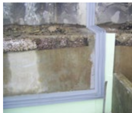
Abdichtung einer Anschlussfuge an ein Bestandsbauwerk mittels FAT130/3 KF Profil
