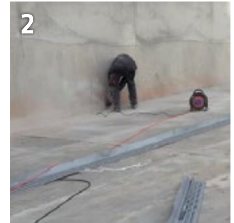
Untergrundvorbereitung durch Anschleifen der späteren Klebefläche
