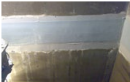
Sanierung einer undichten Arbeitsfuge
