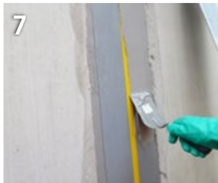
Deckauftrag des Systemklebers bei der Dehnfugenausbildung aufbringen
