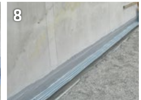
Fertig appliziertes DFT-Fugenbandprofil
