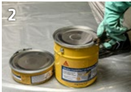
Die Gebinde vorsichtig mit Zange öffnen (dazu Sollbruchstelle am Sprengring benutzen).
