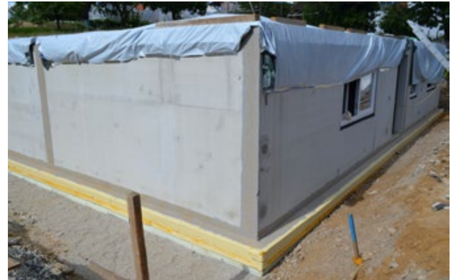
Kombination von Sikadur-Combiflex® TF System mit dem SikaProof® Frischbetonverbundsystem in der Bodenplatte
