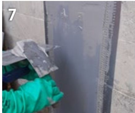
Deckauftrag des Systemklebers bei einer Arbeitsfuge
