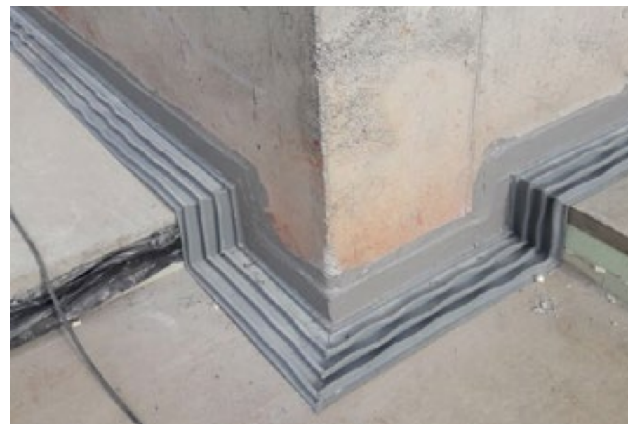
Abdichtung einer Anschlussfuge an ein Bestandsbauwerk mit einem Profil Typ DFT 330/3 KI
