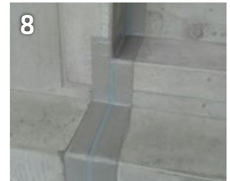
Saubere Klebekanten im Randbereich und im Dehnbereich der Dehnfugenausbildung
