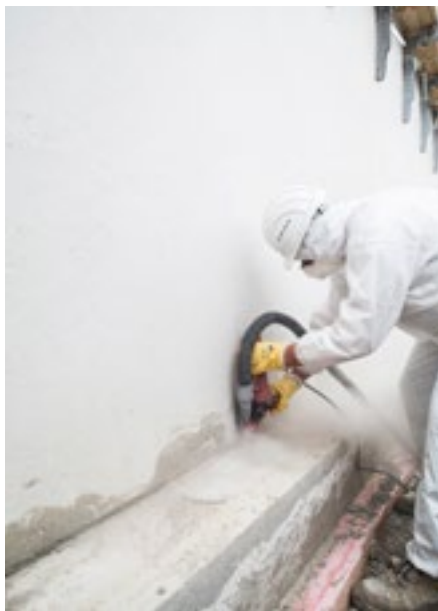
Untergrundvorbereitung durch Anschleifen der Betonflächen
