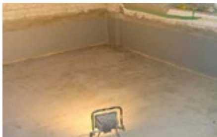
Ablebung in Form einer flächigen Ausbildung als neue Innenwanne bei der Sanierung eines Bestandskellers
