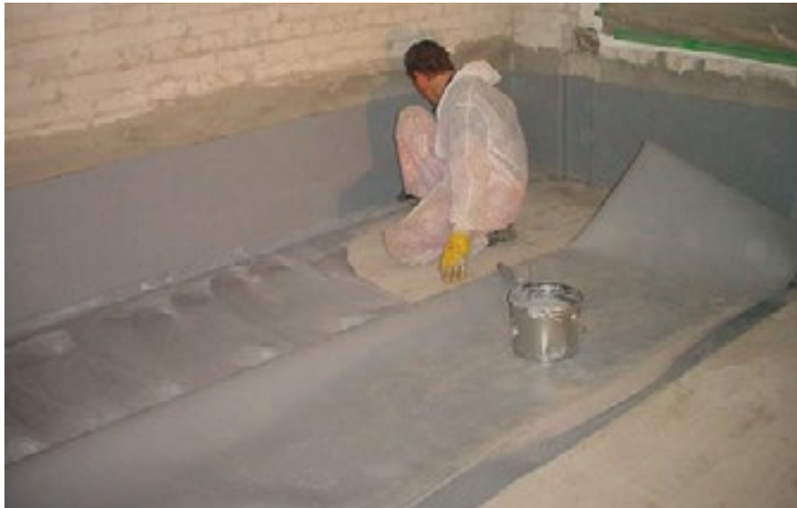
Ablebung in Form einer flächigen Ausbildung als neue Innenwanne bei der Sanierung eines Bestandskellers
