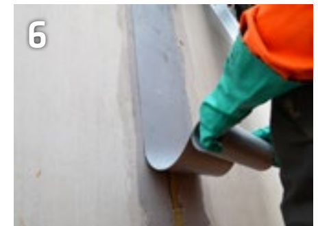
Einlegen des 2 mm Dichtstreifens in das frische Kleberbett im Bereich einer Dehnfuge
