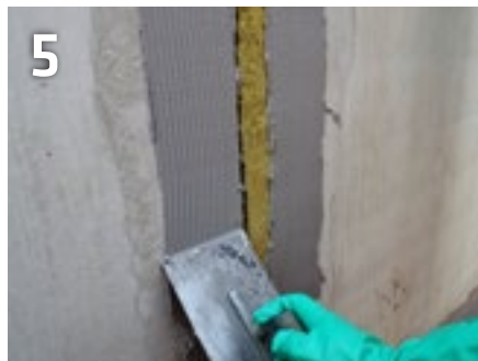
Grundauftrag des Systemklebers mit 4 mm Zahnkelle bei einer Dehnfuge
