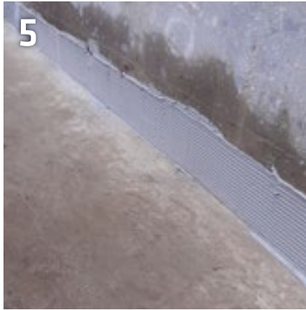
Grundauftrag des Systemklebers für die Verklebung eines DFT Fugenbandprofils
