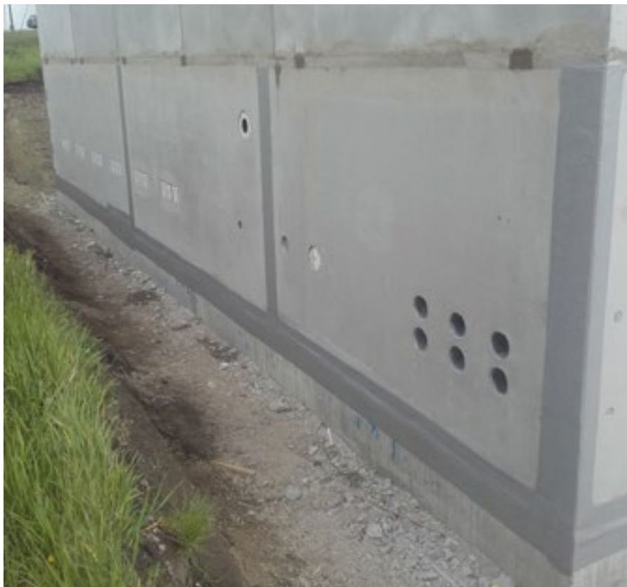
Abklebung von Arbeitsfugen am Beispiel eines Fertigteilkellers
