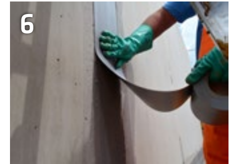
Einlegen des 1 mm Dichtstreifens in das frische Kleberbett im Bereich einer Arbeitsfuge
