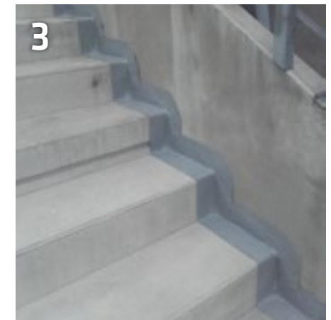
Formteile und Schweißungen herstellen
