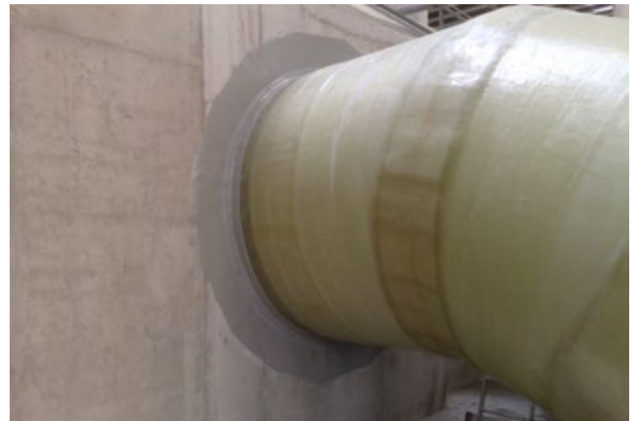
Abdichtung von Rohrdurchführungen in verschiedenen Dimensionen und Materialien
