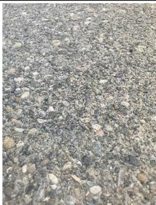
Die Betonoberfläche ist durch Druckluftstrahlen mit festem Strahlmittel bzw. Hochdruckwasserstrahlen (ab 400 bar) so vorzubereiten, dass eine Rautiefenklasse von mind. RT0,3 erzielt wird. Kanten sind zu brechen.
