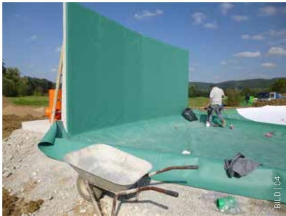
Die Naturteich-Abdichtung wurde mit der FPO- Kunststoffdichtungsbahn Sikaplan WT 5300-15-C realisiert. Die glasvliesarmierte Dichtungsbahn von Sika wurde in einer Dicke von 1,5 Millimetern lose verlegt und anschließend mechanisch sicher befestigt.
