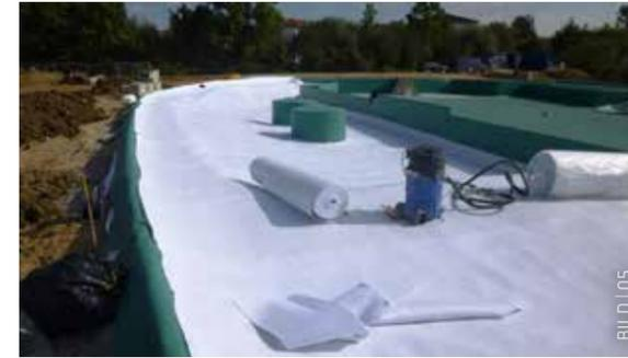
Unter der Dichtungsbahn wurde eine Schutzlage aus Geotextil angebracht.
