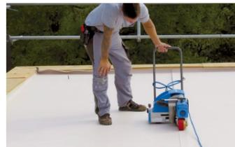
Die Bahnenüberlappungen werden verschweißt. Hierfür bietet sich der Schweißautomat **Sarnamatic® LE** an.
