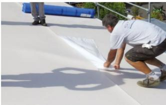
Die Schutzfolie wird seitlich abgezogen und die Dachbahn fortlaufend an den Untergrund angepresst.
