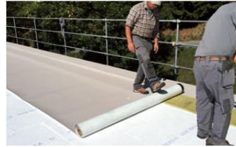
**Sarnafil® TG 76 FSA** wird auf der Dachfläche ausgerollt und ausgerichtet.
