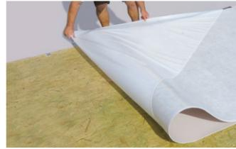
Die Schutzfolie wird am Bahnenende in ca. 45° abgezogen und die Dachbahn angeklebt.
