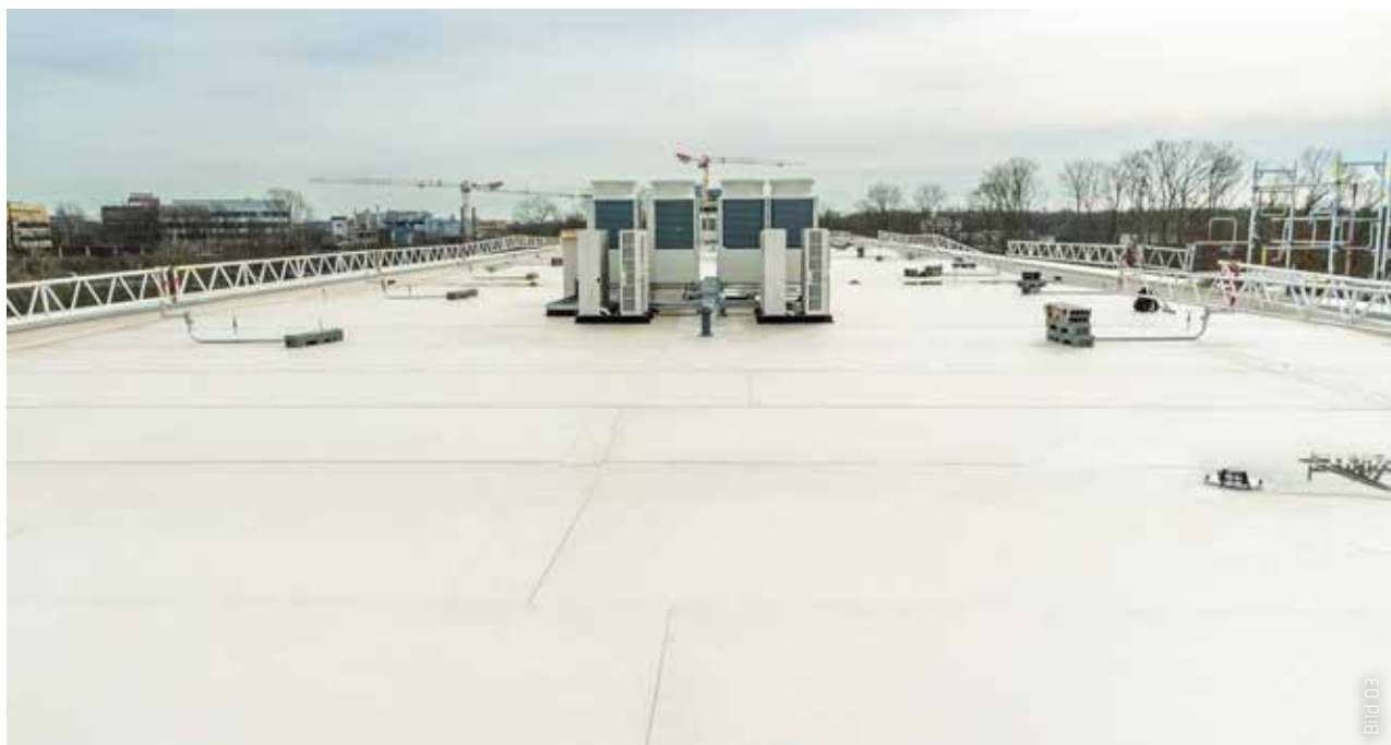
Die insgesamt rund 2.000 qm der Hauptdachfläche wurden mit der Kunststoffabdichtungsbahn Sarnafil® AT-25 abgedichtet.
