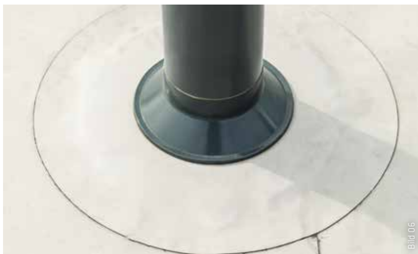
Auch die Sarnafil Kontrollrohre, die eine Dichtigkeitskontrolle von oben ermöglichen, wurden mit Sarnafil® AT-25 eingefasst.
