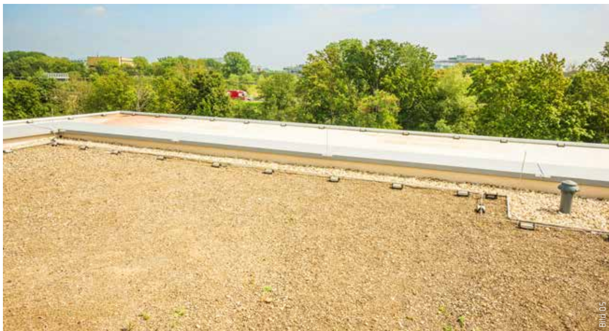
Nach der Abdichtung wurde die Hauptdachfläche für die anschließende Begrünung vorbereitet. Sarnafil® AT-25 ist FLL-geprüft und widerstandsfähig gegen das Durchdringen von Wurzeln.
