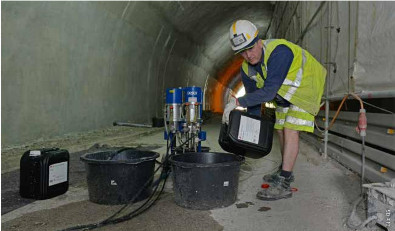
Zur Stabilisation des Injektionsgels Sika® Injection-311 wird es mit dem Dispersionsgel Sika® Injection-315 gemischt.
