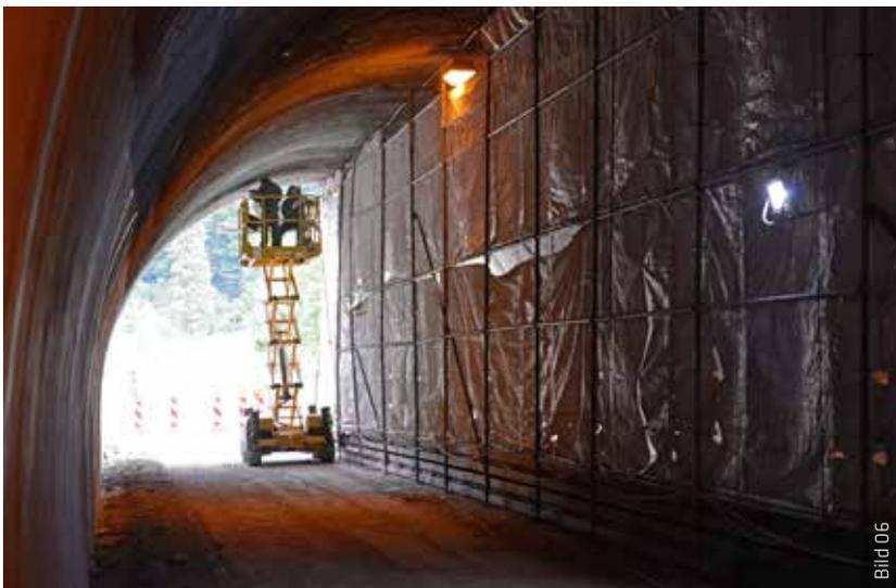
Die Abdichtung rund um die Tunnelschale des Tunnels Spitzingsee war schadhaft und wurde mit Injektionsmaterial von Sika ausgebessert.
