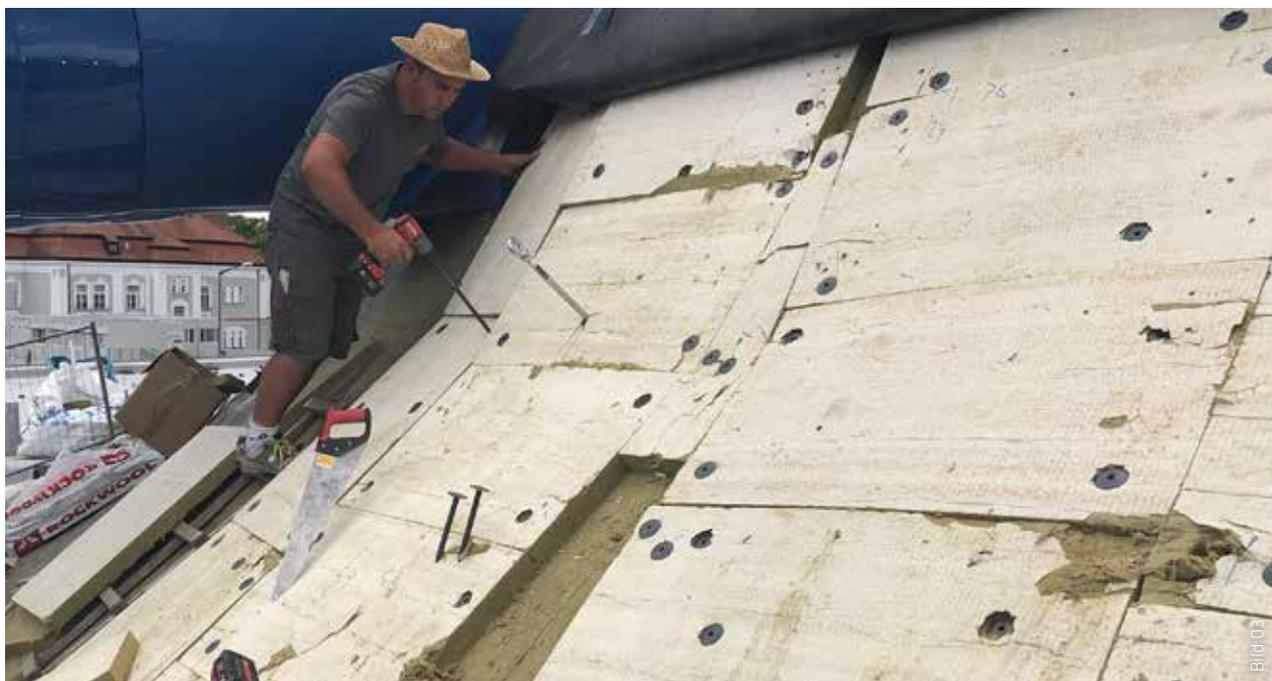
Am Kopf des bis zu 85 Grad geneigten Rutschenturms wurden die Kunststoffdachbahnen mit Klebeband fixiert und dann die herunterhängenden Bahnen in der Naht mechanisch befestigt und verschweißt.
