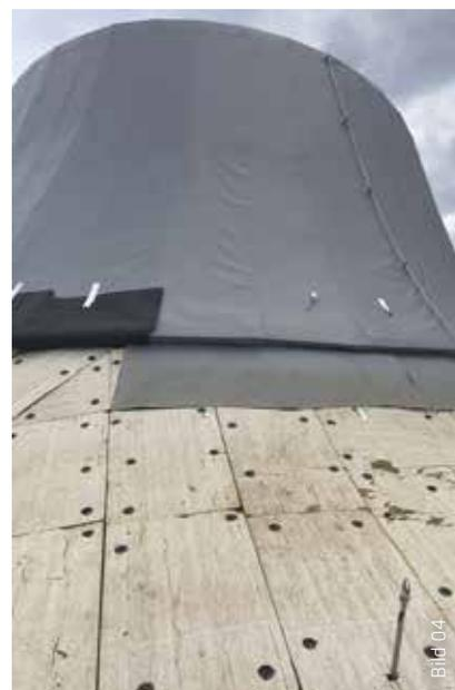
Dämmung und Dachabdichtungsmaterial mussten in kleinteiliger Handarbeit verlegt werden, um die verschiedenen Dachneigungen zu erreichen.
