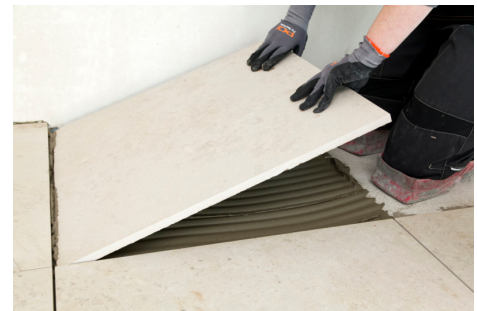
Mit PCI Carrament ® grau können Naturwerksteinbeläge sicher im Mittelbettverfahren verlegt werden.
