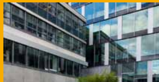
KLEBEN UND DICHTEN IM FASSADENBEREICH
