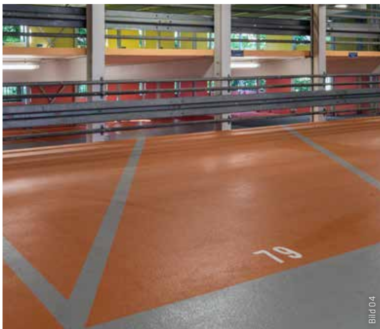
Nach der Sanierung mit dem OS-10 Beschichtungssystem Sika CarDeck® Professionell TF N von Sika Deutschland erstrahlen die Parkflächen im neuen Look.
