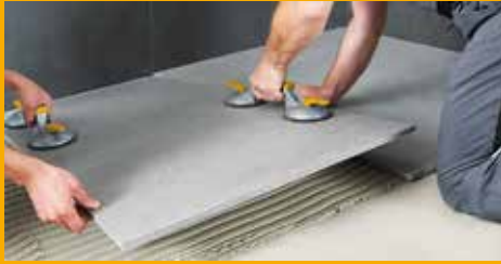
FLIESEN-, WAND- UND FUSSBODENTECHNIK
