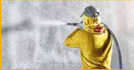
BETONSCHUTZ UND INSTANDHALTUNG
