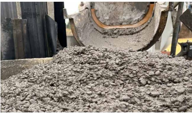
Der Beton mit der Kombination aus Makro- und Mikrofasern wurden als F3 Beton geliefert.
