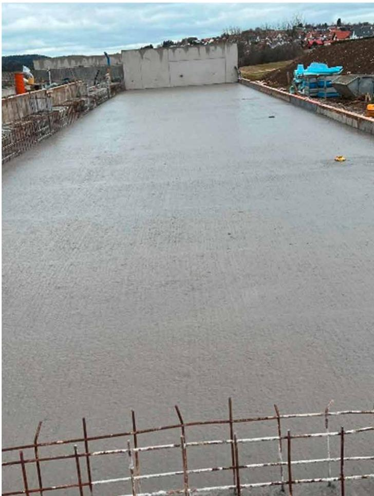
Ein abschließender Besenstrich strukturierte die frische Betonoberfläche.
