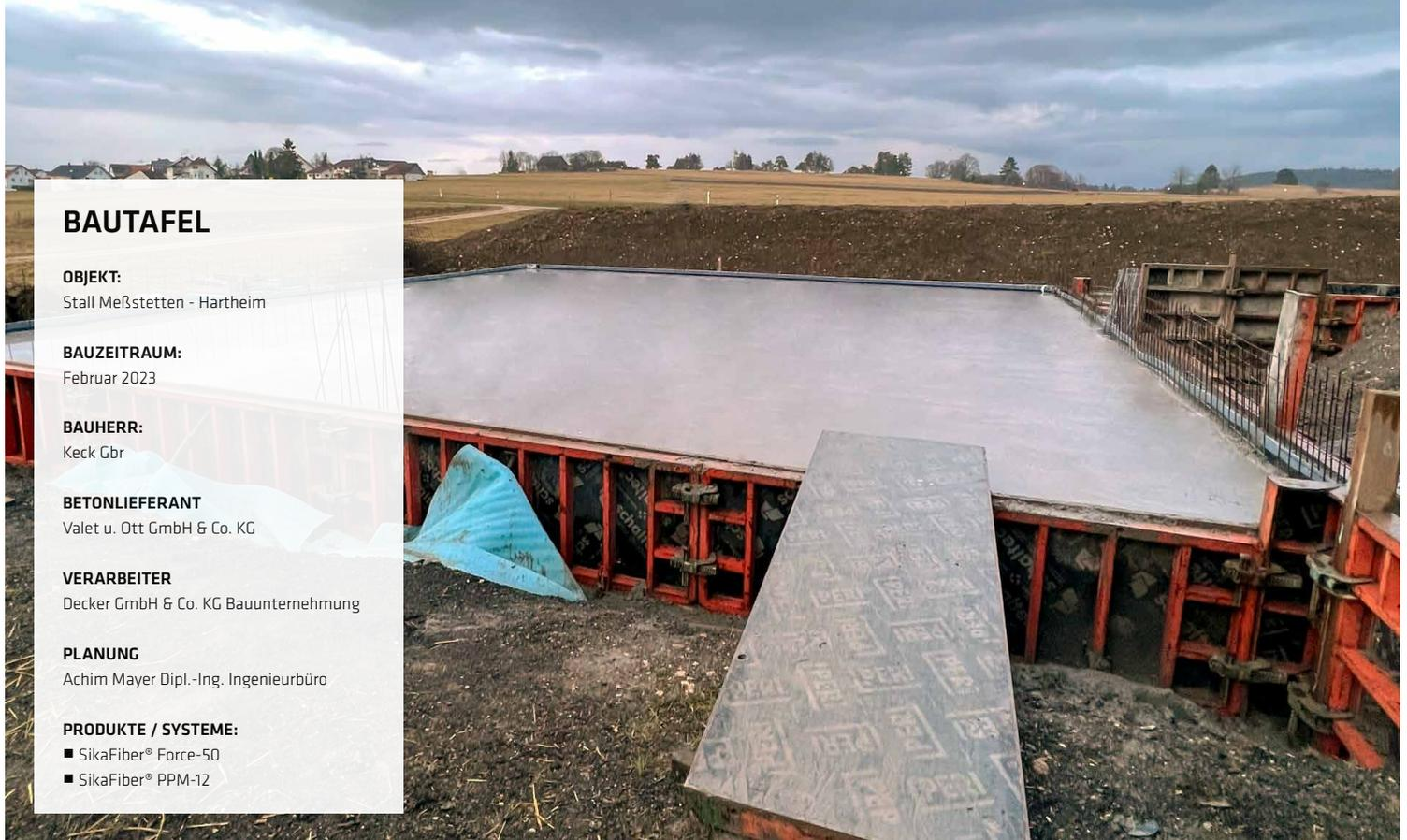
Der Beton wurde mittels Rüttelflasche verdichtet und anschließend abgezogen.
