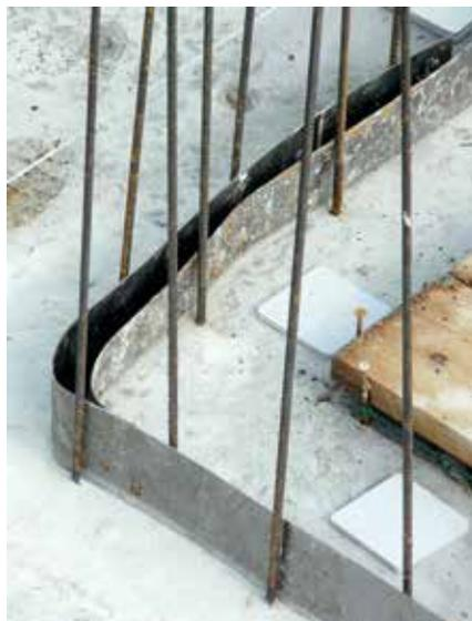
**Abb. 12:** Beispiel für einen nicht zulässigen Überlappungsstoß unbeschichteter Fugenbleche
