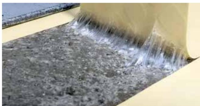
Abb. 5: Kontaktverklebung einer nachträglich applizierbaren Verbundbahn
