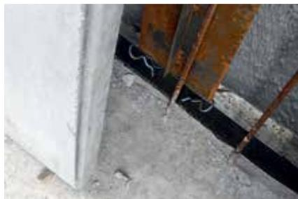
Abb. 17: Fachgerechter Anschluss von Sollrissfugenschienen an das beschichtete Fugenblech in der Bodenplatte
