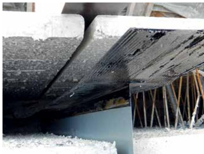
**Abb. 16:** Beispiel einer Sollrissfugenschiene
