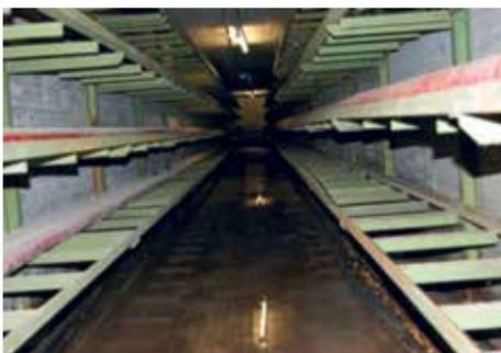
**Abb. 12:** Ungünstige Anordnung von TA-Komponenten direkt an der Außenwand.
