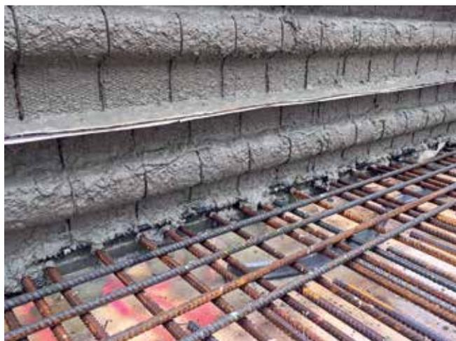
Abb. 13 und 14: Faserzementleiste als Unterlaufschutz im Bereich der Arbeitsfugenabstellung
