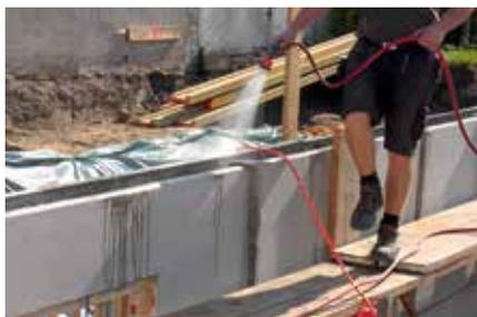
**Abb. 24:** Vornässen der Elementwandschalen vor dem Betonieren
