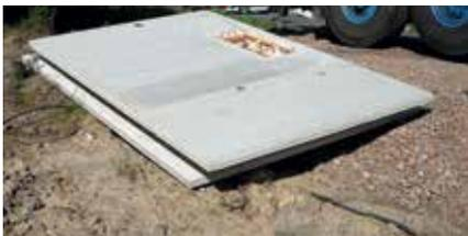
Abb. 20: Nicht fachgerechte Zwischenlagerung von Elementwänden
