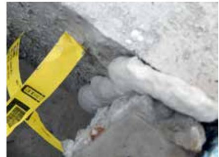
Abb. 23: Bauschaum, der unkontrolliert in den Zwischenraum der Elementwand eingedrungen ist und den Ortbetonquerschnitt reduziert
