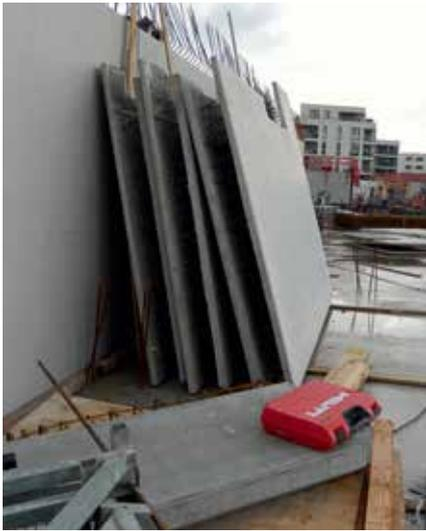
Abb. 19: Fachgerechte Zwischenlagerung von Elementwänden
