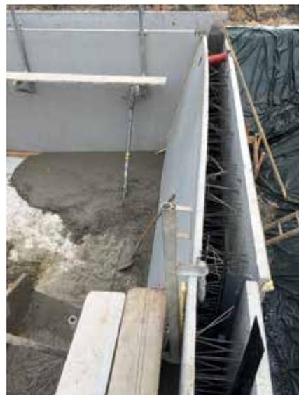
**Abb. 27:** Aufbrechen der Elementwand infolge zu großer Betoniergeschwindigkeit
