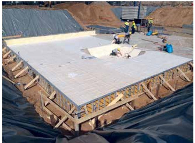
Abb. 11 und 12: Verlegung von FBV-Bahnen auf Perimeterdämmung und Magerbetonsauberkeitsschicht
