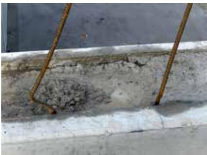
Abb. 28: Absetzen des Betons am Wandkopf
