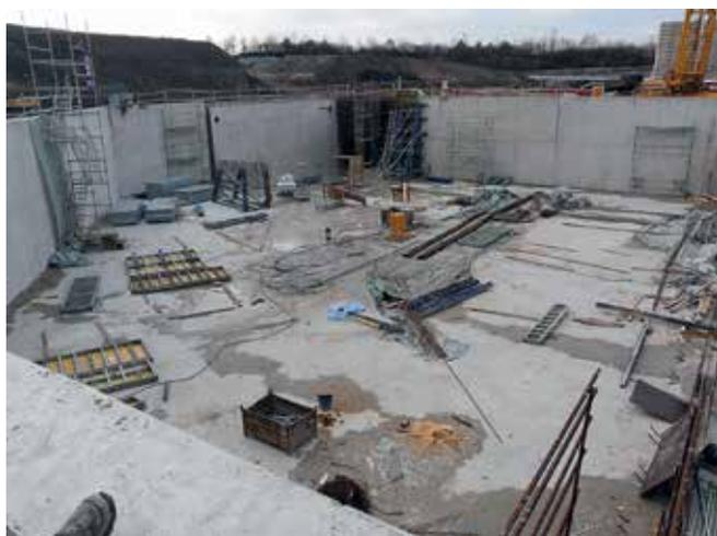
Abb. 1: Wasserundurchlässiges Bauwerk aus Beton
