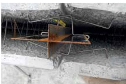
Abb. 16: Beispiele für Sollrissfugenschienen in einem Elementwandstoß (links: Sollrissfugenschiene, die an einer der Fertigteilplatten befestigt werden muss; rechts: Sollrissfugenschiene, die »selbsttragend« ist und am Wandkopf mit speziellen Bügeln fixiert wird)
