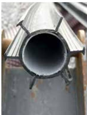
**Abb. 15:** Dichtrohr zur Abdichtung von Sollrissquerschnitten in Wänden (links) und Ausbildung des Fußpunktes beim Einbau von Dichtrohren (oben)
