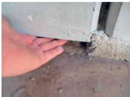
**Abb. 26:** Kiesnester und Gefügestörungen im Bereich des Sohle-Wand-Anschlusses einer Elementwand
