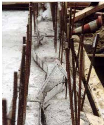
**Abb. 5:** Unbeschichtetes Fugenblech in der Arbeitsfuge zwischen Bodenplatte und Wand mit einer Betonaufkantung
