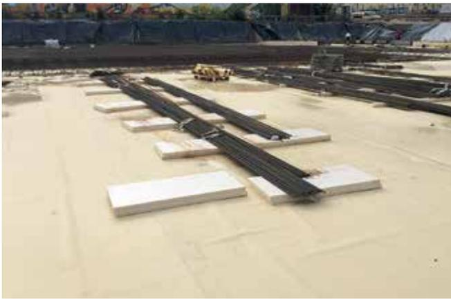
Abb. 17: Lagerung von Bewehrungsstahl auf fertig verlegter Fläche
