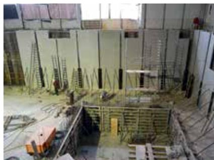
Abb. 1: Beispiele für WU-Konstruktionen aus Elementwänden
