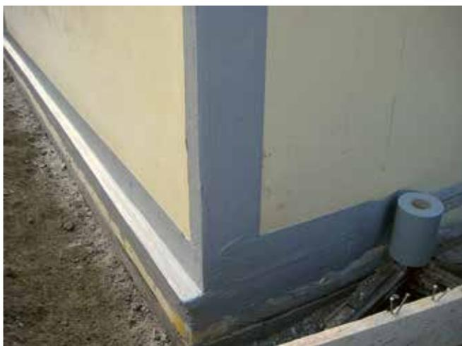
Abb. 15: Abklebung von Arbeitsfugen mit dem Tricoflex® Abklebesystem
