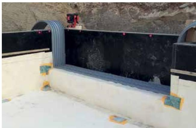
Abb. 16: Außenliegendes Dehnfugenband, Typ Tricoflex® DFT 330/3
