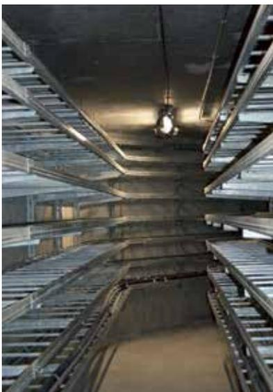
Abb. 4: Beispiel für behinderte Zugänglichkeit durch technische Ausrüstung vor WU-Wänden (hier: Kabeltrassen)
