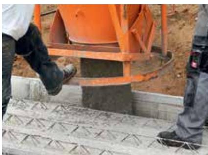
**Abb. 25:** Fachgerechtes Betonieren mit einem passenden Betonierschlauch und kleiner Fallhöhe (oben) bzw. nicht fachgerechtes Betonieren mit zu großer Fallhöhe (unten)
