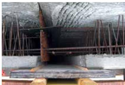
**Abb. 9:** Biegesteifer Stoß einer Elementwand
