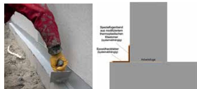
Abb. 14: Abdichtung der Arbeitsfuge mit einem vollflächig, mit einem starren Epoxidharzkleber aufgeklebten streifenförmigen Fugenabdichtungsband
