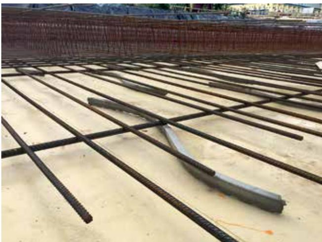
Abb. 18: Lageversetzt angeordnete Abstandshalter aus Faserzement
