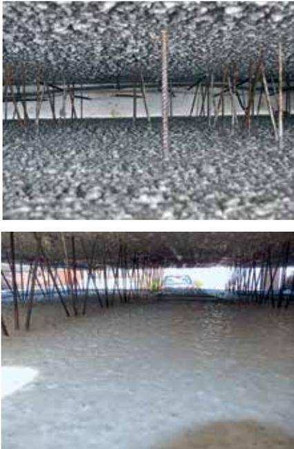
**Abb. 2:** Fertigteilplatten, bei denen die Anforderungen an die Rauigkeit erfüllt (oben) bzw. nicht erfüllt (unten) werden.
