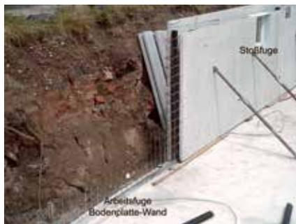
Abb. 5: Abdichtung der Elementwand mit Fugenband in der Arbeitsfuge Bodenplatte – Wand und einem Dichtrohr in der Stoßfuge
