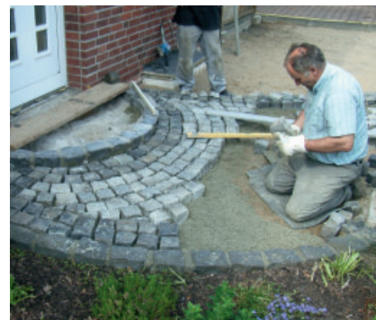
Verlegen von Kleinpflaster in PCI Pavifix DM.
