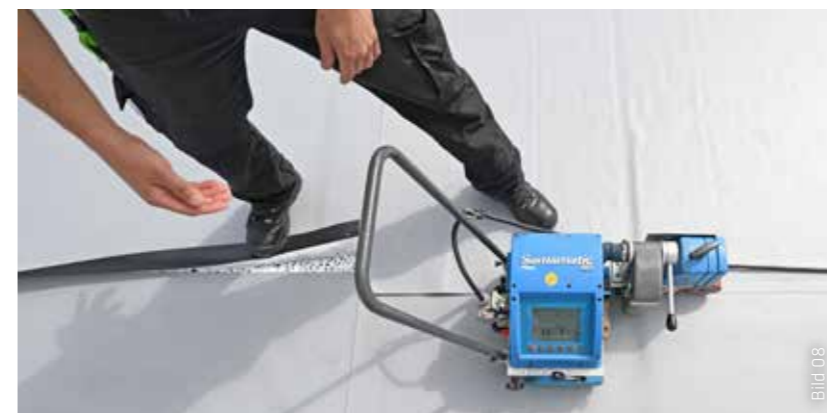
In der Fläche wurden die Dachbahnen mit dem Sarnamatic®-Automaten verschweißt.
