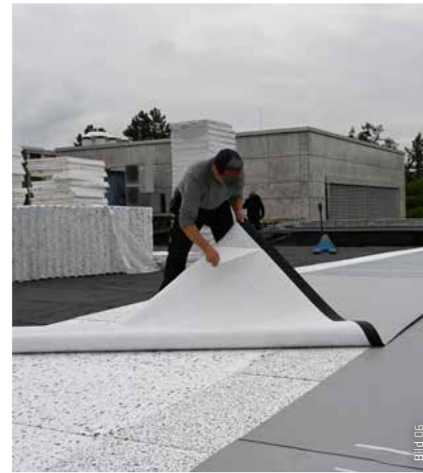
Anschließend wird der Liner der Abdichtungsbahn Sarnafil® AT-18 FSA abgezogen und die Bahn auf der Dämmung befestigt und verklebt.
