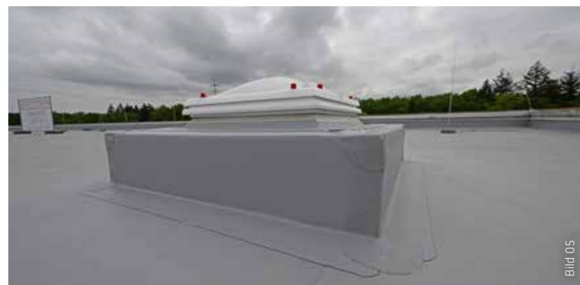
An der einzigen Lichtkuppel auf dem Dach wurde die Sarnafil® AT-18 FSA hoch geführt und mit einer Anschlusschiene befestigt.
