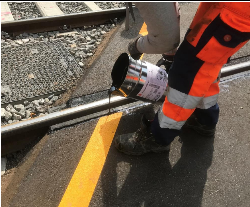
Verguss der Schienenfuge mit Sikaflex®-406 KC
