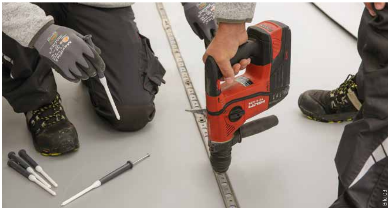
Mit Sarnabar-Befestigungsprofilen fixiert, ist das Dach optimal gegen Windsog-Lasten gesichert – das garantiert Sika für 25 Jahre.
