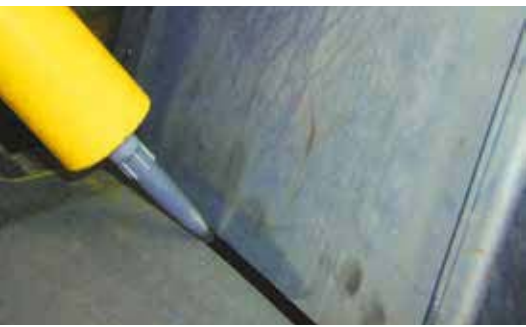
»2 Schweißnahtabdichtung vor dem Pulverlackierungsprozess mit einem Epoxidharz/Polyurethan-Hybrid-Klebstoff
