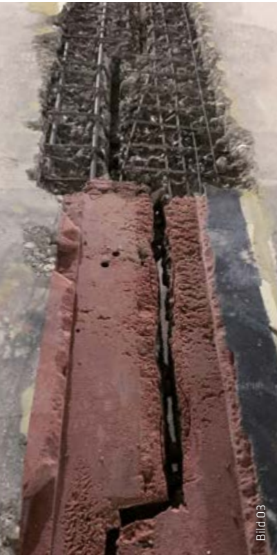
Unter den Metallprofilen der Bauwerksfugen hatte das Tausalzwasser den Beton bereits stark angegriffen.
