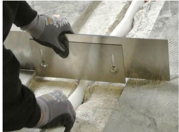
Höhenjustierung des Randdämmstreifens mittels einstellbarer Traufel.
