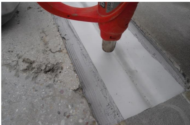
Die Anpassung des Sikadur-Combiflex® TF Dichtstreifens an den Fugenverlauf kann durch vorsichtiges Erwärmen mittels Heissföhn erfolgen.
