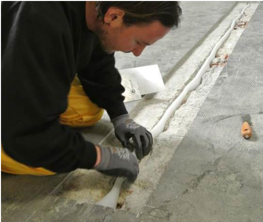
Einbau des Randdämmstreifens.
