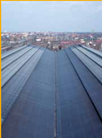
Die Forderung des Denkmalschutzes nach einer anthraziten Dachhaut wurde mit einer Sonderanfertigung von Sarnafil gelöst.
