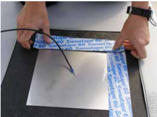
Verlegung einer Kontaktplatte des Sika Roof Control Systems. Sie dient als Messpunkt für die Überprüfung der Dichtheit des Flachdachs.
