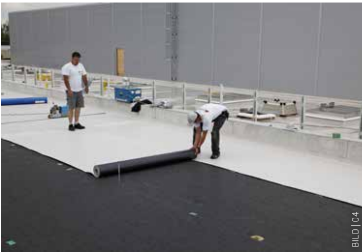
Das elektrisch hochleitfähige Spezialglasvlies des Sika Roof Control Systems zur Leckageortung wird zwischen Dämmung und Abdichtung verlegt.
