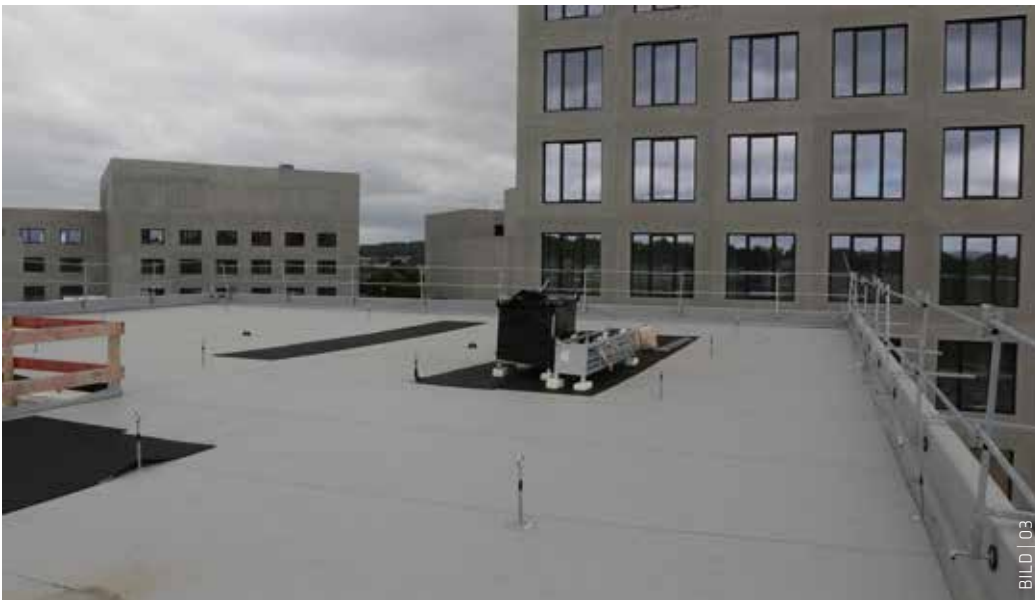
Für die Abdichtung der Flachdächer der Gebäude im Leitz-Park Wetzlar wurden 6000 m 2 Sarnafil TS 77-18 Kunststoffbahnen verlegt.
