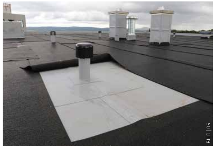
Über den Sarnafil TS 77-18-Kunststoffbahnen zur Dachabdichtung wurden Bautenschutzmatzen verlegt.
