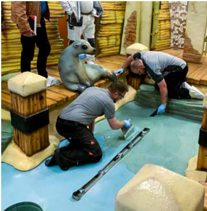
Das Material wird mit der Zahntraufel verteilt.
