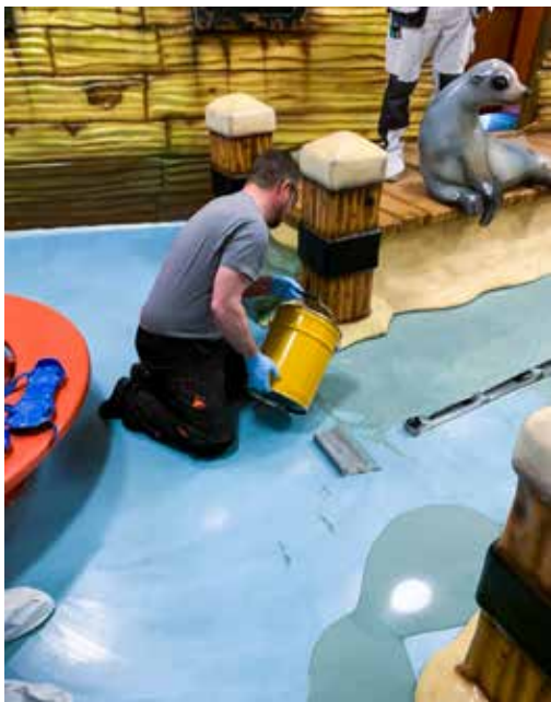
Der bestehende Boden wurde zunächst angeschliffen und mit dem emissionsarmen Sikafloor®-701 grundiert.
