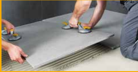
FLIESEN-, WAND- UND FUSSBODENTECHNIK
