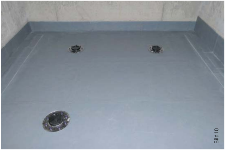
Eindichten von Bodenabläufen mittels Flanschsystemen.
