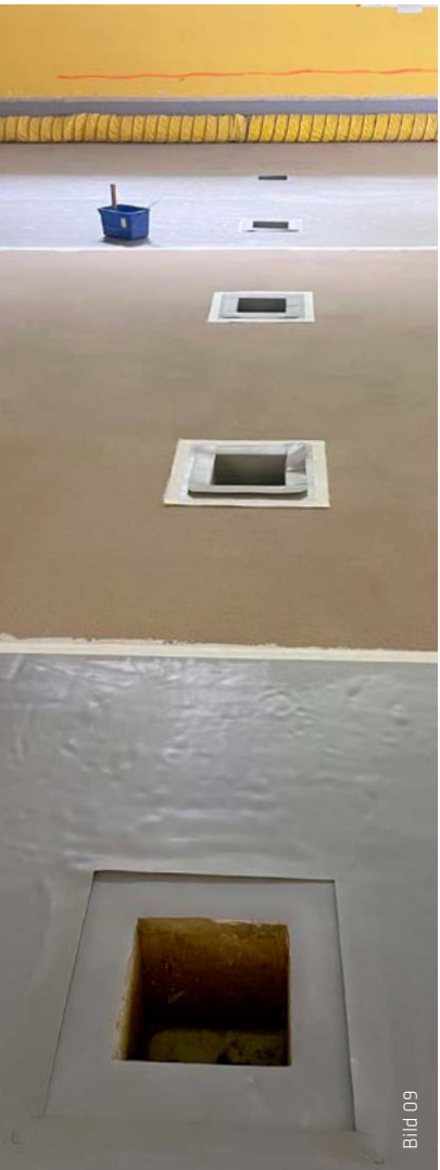
Abklebung der Aufkantung zu aufgehenden Bauteilen.
