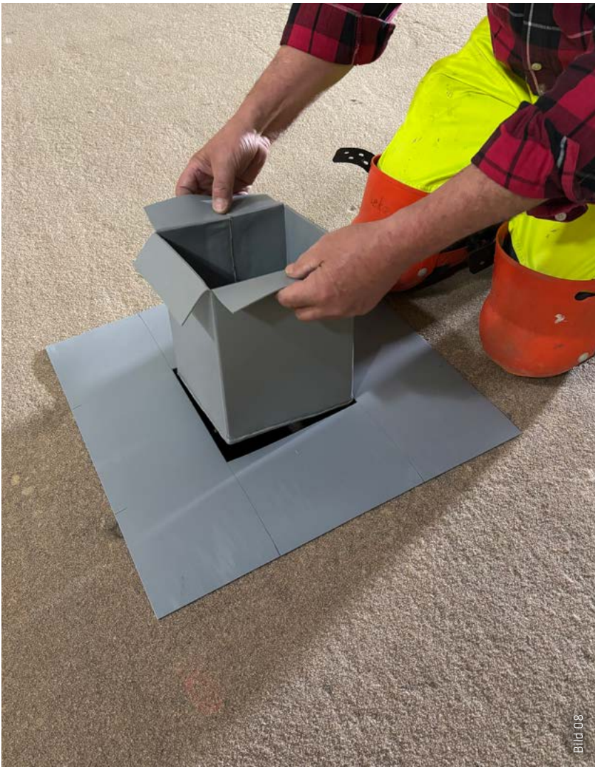
Herstellen von Formteilen für die Bodeneinstandshülsen.
