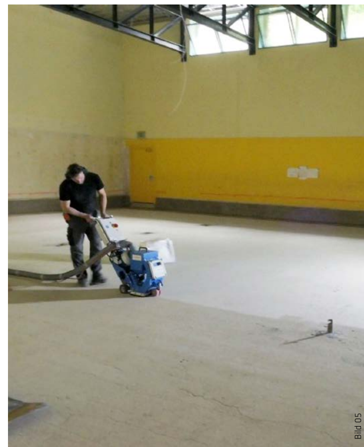
Vorbereiten der Flächen durch Kugelstrahlen.
