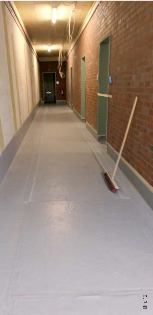
Flächige Abdichtung in den Nebenräumen und Fluren.
