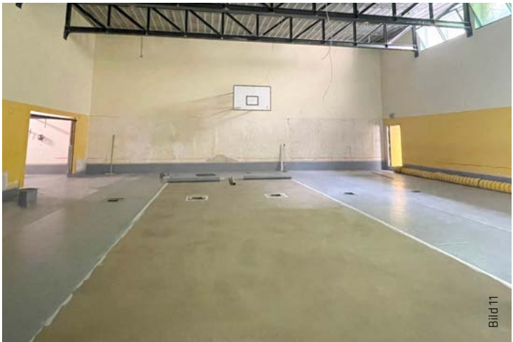
Flächige Abklebung mit Sikadur-Combiflex® TF Dichtstreifen in 200 cm Breite.
