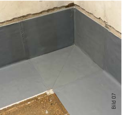
Abklebung der Aufkantung zu aufgehenden Bauteilen.
