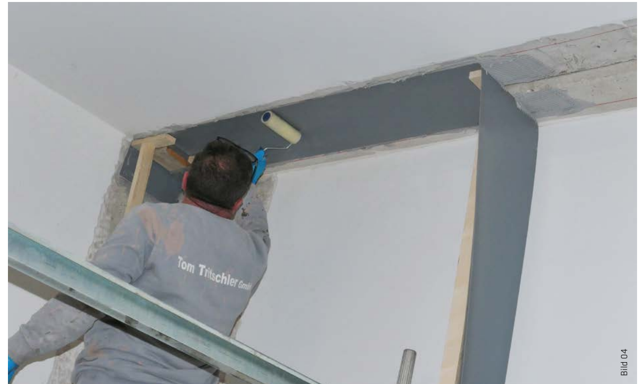
Nachträgliche Abdichtung der zu sanierenden Bewegungsfuge mit dem 2 mm Dichtstreifen des Sikadur-Combiflex® TF Systems.
