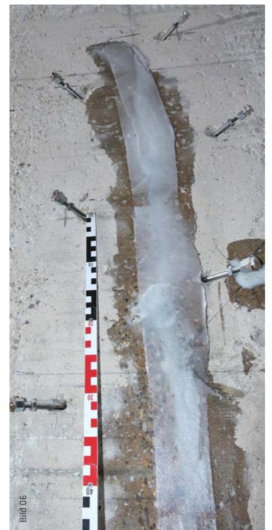
Riss- und Flächeninjektionen mit SikalInject®-201 DE auf PU-Basis.
