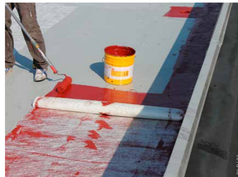
In die noch feuchte erste Abdichtungsschicht wird das Sika Reemat Premium Glasvlies eingebettet.
