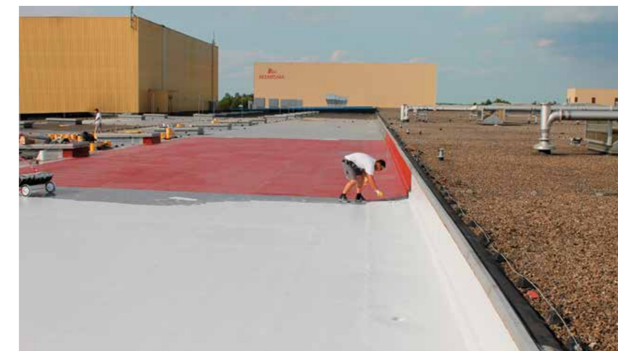
Im Anschluss folgte die zweite Lage der Deckbeschichtung in Perlgrau. Die unterschiedlichen Farbtöne der einzelnen Abdichtungsschichten ermöglichen eine gleichmäßige Schichtdicke und Kontrolle des Arbeitsfortschritts.
