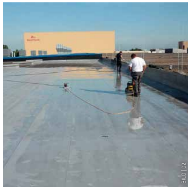
Vor der Verarbeitung des Flüssigkunststoffes musste die Dachfläche mit Hochdruck gereinigt werden.
